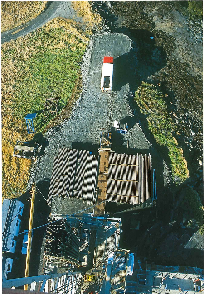
Haustið 1994 lét Hitaveita Seltjarnarness bora nýja 2712 m djúpa vinnsluholu fyrir veituna. Áætlað er að úr holunni megi dæla amk. 30 l/s af 115-130°C heitu vatni. Ljós. Jósef Hólmjárn.
