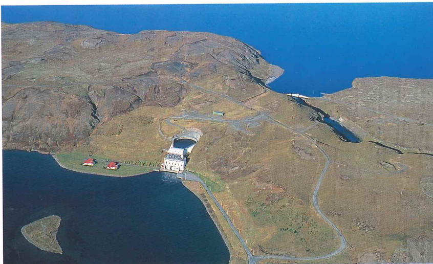
Steingrímsstöð í Sogi, 26 MW, tekin í notkun 1959. Virkjað er 20 m fall Efra Sogs um jarðgöng úr Þingvallavatni til Úlfliótsvatns.
