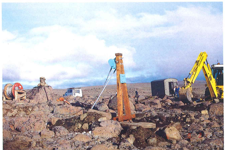
Nýr kláfur í smíðum við Eyfirðingavað í Austari Jökulsá í Skagafirði. Bjarni Kristinsson. The construction of a new cable-way on river Austari Jökulsá, in Skagafjörður, Northern Iceland.
