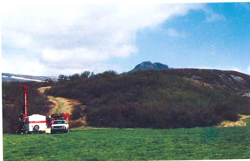
Borun rannsóknarholu við Bifröst í Borgarfirði síðastliðið vor. Hún leiddi til borunar vinnsluholu um haustið og er nú verið að tengja hitaveitu fyrir Samvinnuháskólann. Guðmundur Ó. Friðleifsson. Thermal gradient drilling at Bifröst, Western Iceland.
