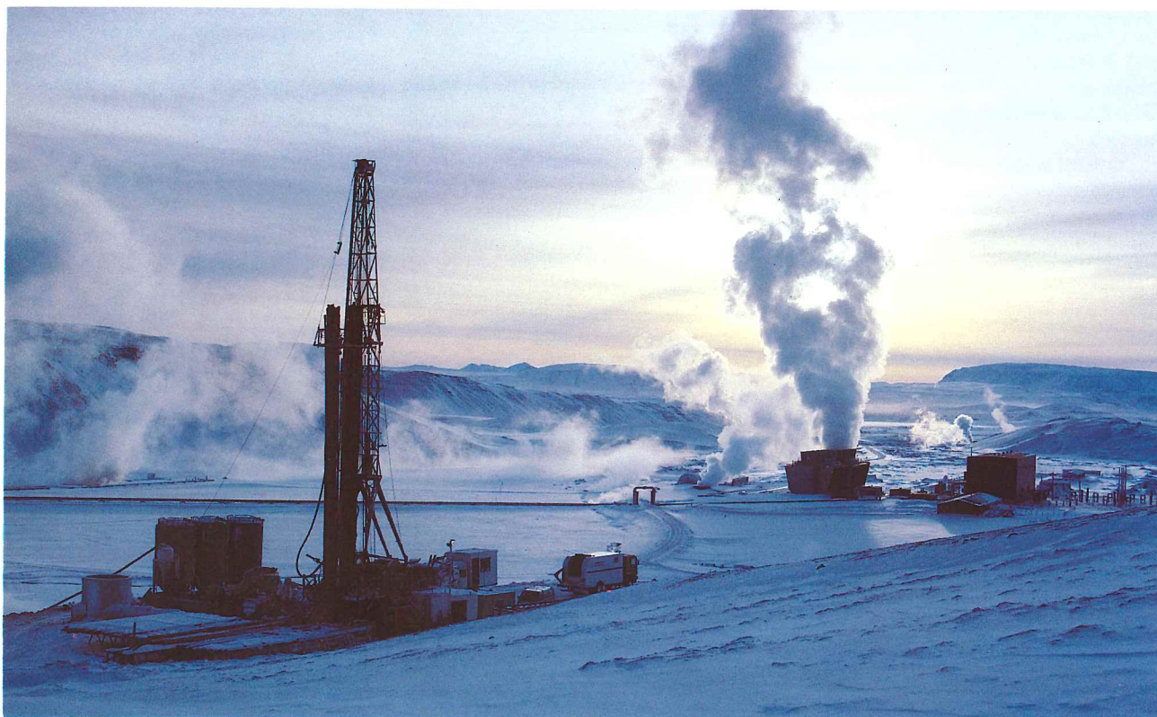
Gufubor við dýpkun holu KG-26 í Kröflu í nóvember 1991. Kröflustöð í baksýn. Jósef Hölmjárn. Drilling of well KG-26 for the Krafla Geothermal Power Plant.
