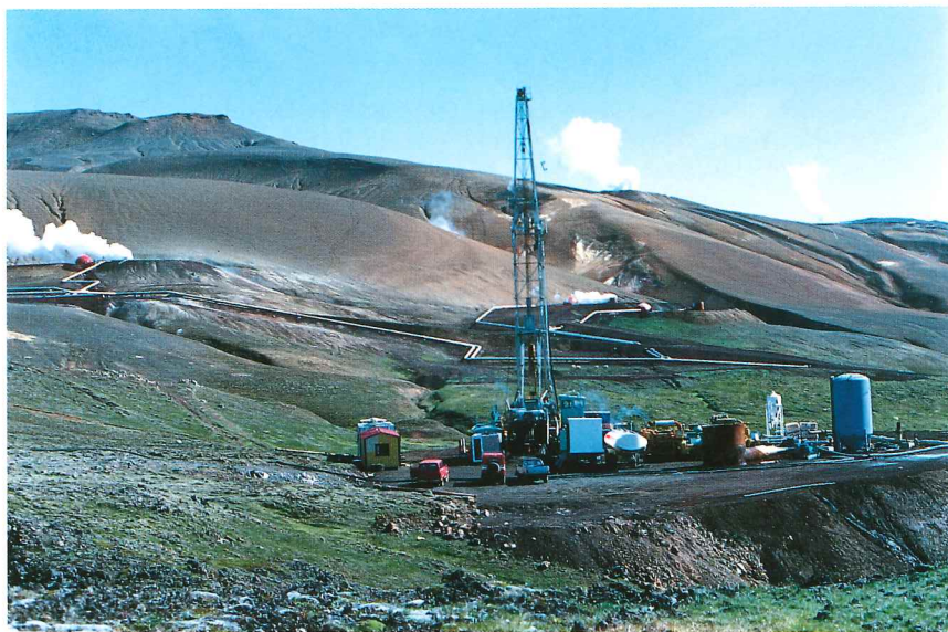
Borun eftir lágþrýstigufu í Kröflu árið 1988 – Hola KG-24. Ljós./photo Ásgrímur Guð- mundsson.
