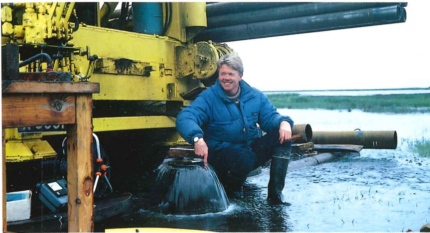
Borun holu N-2 í Öxarfirði til öflunar fersks vatns til fiskeldis. Ljósmynd. / photo Björn Benediktsson.
