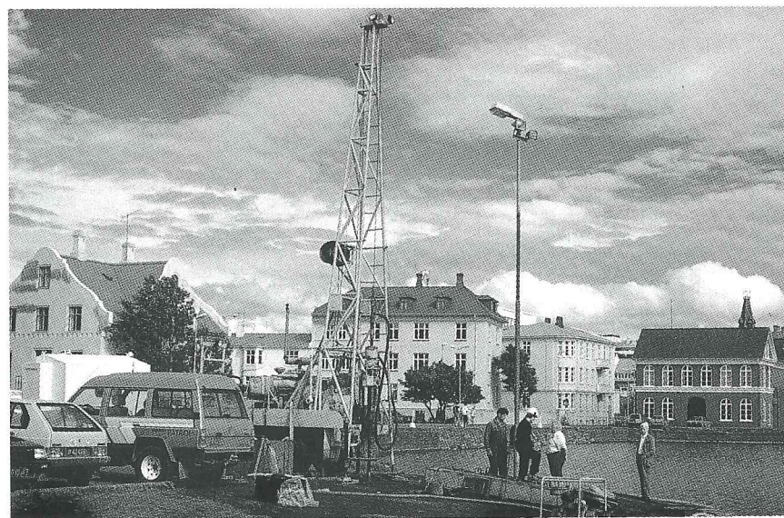
Jarðborinn Dugandi frá Jarðborunum hf. að bora kjarnaholu í grunn væntanlegs ráðhúss Reykjavíkur, vegna rannsókna á grunnvatni og tæknilegum eiginleikum berggrunns. (Ljósm. Birgir Jónsson).
