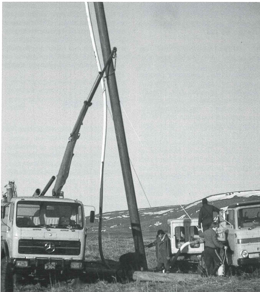
Skolborun í Öxarfirði. Heimamenn voru aðstoðaðir við tilraunir til að afla sjávar úr sandi við Skógalón. 12 m hátt og 12" vítt stálrör var reist upp á endann og vatni dælt á. Seig þá rörið undan eigin þunga. Þannig var útbúin 40 m djúp tilraunavinnsluhola (ljósm./photo, Oddur Sigurðsson).
