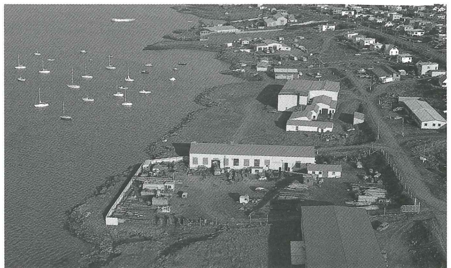
Lager Jarðborana ríkisins í Vesturvör í Kópavogi (ljósm./photo, Oddur Sigurðsson). The State Drilling Contractors' warehouse.
