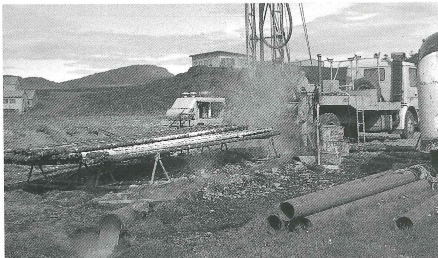
Fyrirhuguð er hitaveita til 26 bæja í Ölfushreppi frá þessari borholu í Gljúfurárholti sem gefur 20 l/s af 59 gráðu heitu vatni (ljósm./photo, Kristján Sæmundsson).
