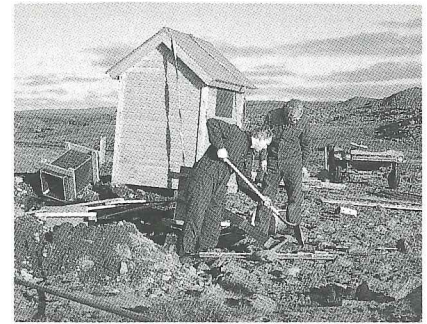
Vatnshæðarsíríti í byggingu við Hvítá í Árnessýslu undir Bláfelli (ljósm./photo, Snorri Zóphóníasson).
