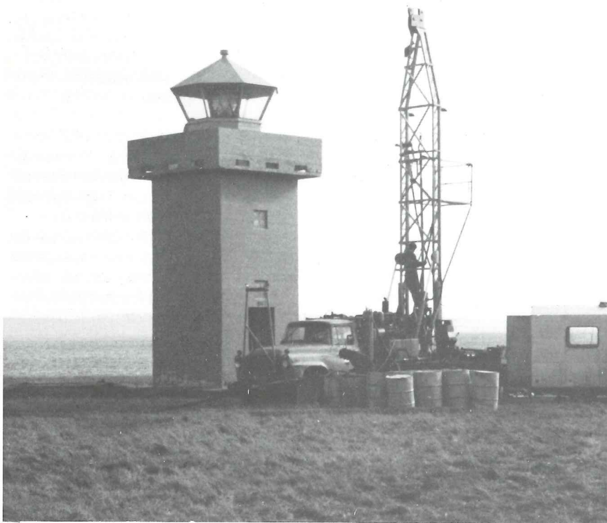
Kjarnaborun við vitann í Flatey á Skjálfa haustið 1982. Rannsóknir á kjarnanum leiddu í ljós að undir eyinni eru setlög, en ekki fannst vottur af olíu. Holan er aðeins 550 m djúp, og líklegt er að setlöggin séu mun þykkari. Ljósmynd: Margrét Kjartansdóttir.
