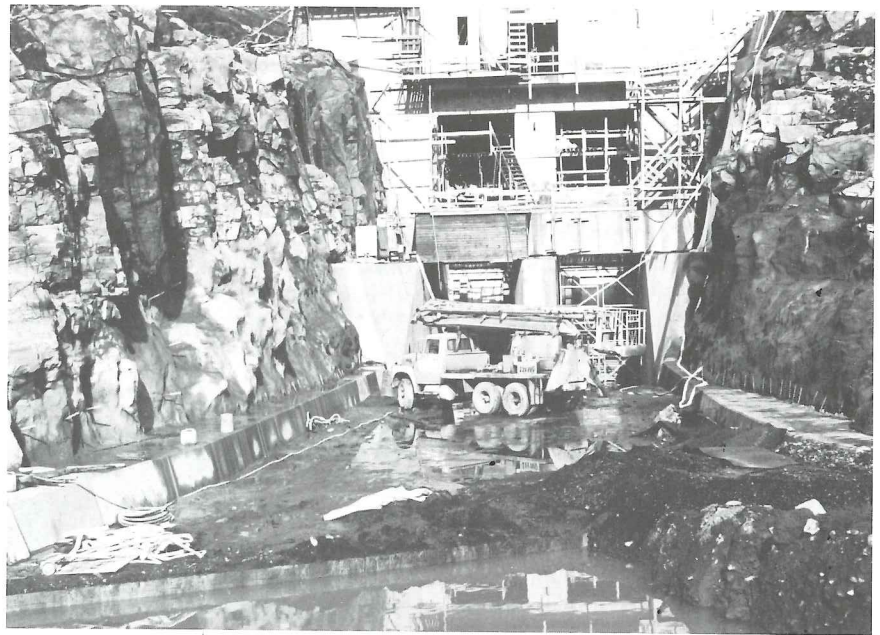
Lokuvirki í botnrásarskurði Sultartangastíflu í ágúst 1983. Framkvæmdum við stífluna lauk að mestu á árinu. Á meðan á þeim stóð voru jarðfræðilegar aðstæður bornar saman við niðurstöður úr rannsóknum til undirbúnings stíflugerðar. Ljósmynd: Björn Jónasson.
