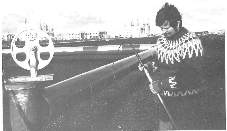
Unnið að eftirliti með vinnslu jarðhita í Svartsengi. Reglubundið eftirlit með hita, þrýstingi og efnasamsetningu, auk söfnunar upplýsinga um rennsli og vatnsborðsstöðu á jarðhitasvæðum í vinnslu, er fastur þáttur í starfsemi Jarðhitadeildar. Ljósmynd: Sverrir Þórhallsson.
