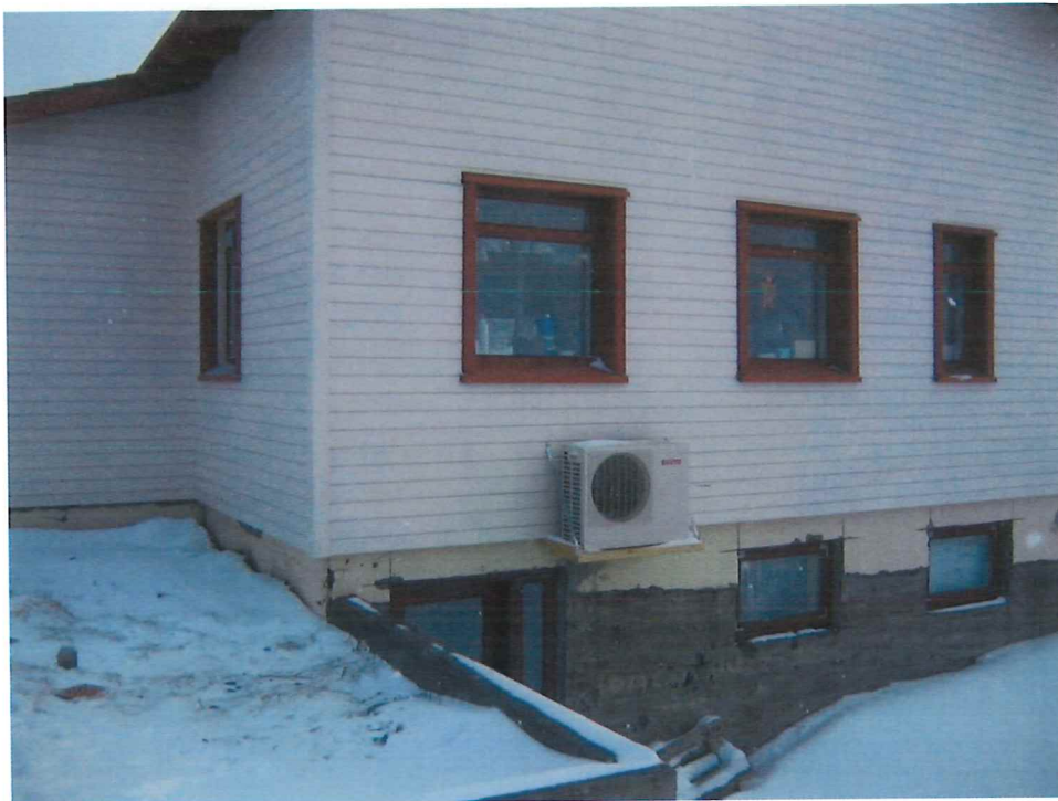
Mynd 5 Varmadælu er komið fyrir við bakdyr. Bil er haft milli húss og bakhluta, þar sem loftinntakið er. Aðgengi er gott og blástur viftunnar tryggir að snjór safnast ekki um of á grindina.
