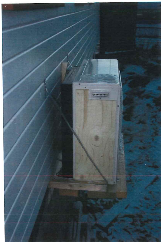
Mynd 8 Vatnskassi við loftinntak varmadællunnar breytir varmadællunni með einföldum hætti úr loft/vatn í því sem næst vatn/vatn varmadælu. Vatnskassanum er haganlega fyrirkomið lengst til vinstri næst húsveggnum. Ljósmynd: Jónas Baldursson.
