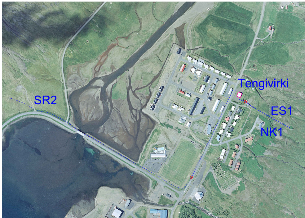
Mynd 1. Staðsetning mælipunkta á jarðstrengjum í Eskifirði.
