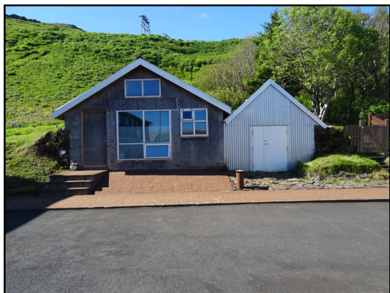
Útihús SF-205:082, horft til norðurs.
