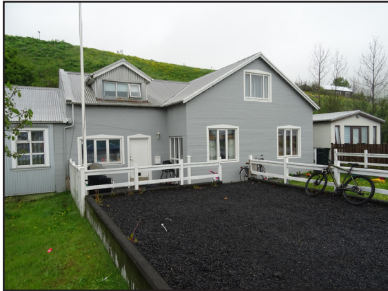
Hús SF-205:119, horft til norðurs.
