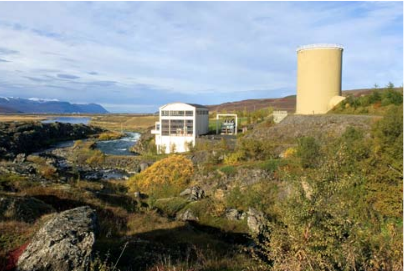
Laxárstöð II. Laxárvirkjun gegndi lykilhlutverki í rafvæðingu á Norðurlandi. Akureyringar höfðu frumkvæði að virkjun Laxár þegar ráðist var í framkvæmdir við Laxárstöð I. Ríkið gerðist meðeigandi Akureyrarbæjar í Laxárvirkjun árið 1950 og árið 1983 var hún sameinuð Landsvirkjun.
