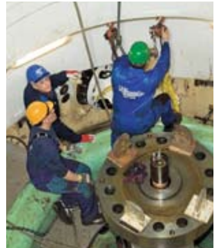
Viðgerð og endurbætur í Ljósafossstöð, elstu virkjuninni í Söginu.
