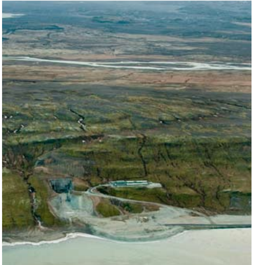
Búðarháls. Hér verða framkvæmdir til undirbúnings Búðarhálsvirkjun sumarið 2010.
