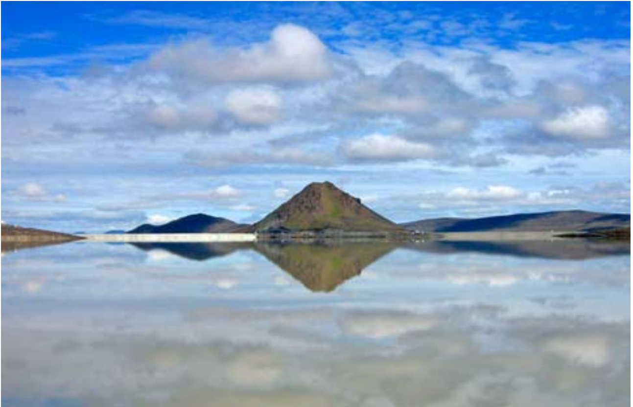
Háslón Kárahnjúkavirkjunar er 57 ferkílómetrar að stærð. Hér er Fremri-Kárahnjúkur fyrir miðri mynd, Kárahnjúkastífla til vinstri og Desjarárstífla til hægri.
