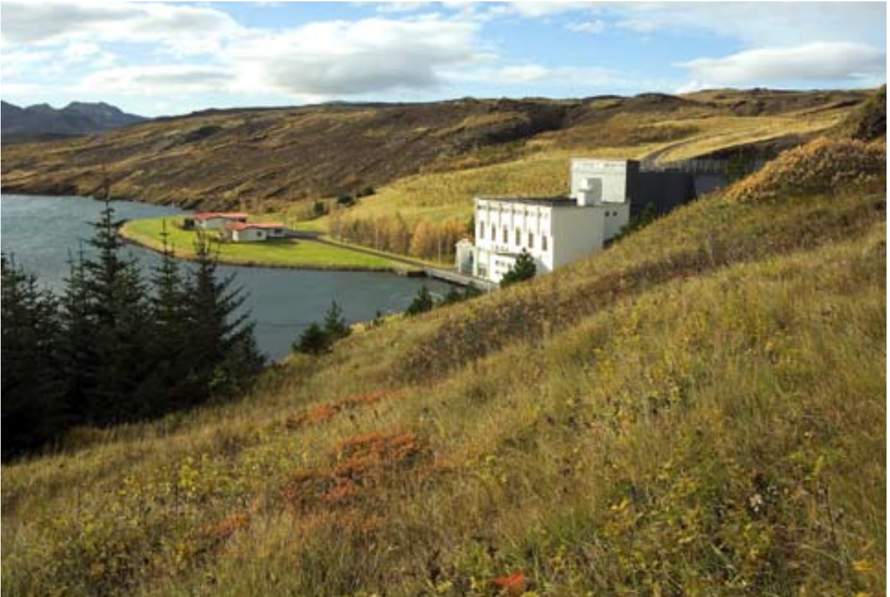
Í Steingrímsstöð er virkjað fall Efra-Sogs úr Þingvallavatni í Úlfjótuvatn. Stöðin var tekin í gagnið árið 1959. Hún er kennd við Steingrím Jónsson, rafmagnsstjóra Reykjavíkur.
