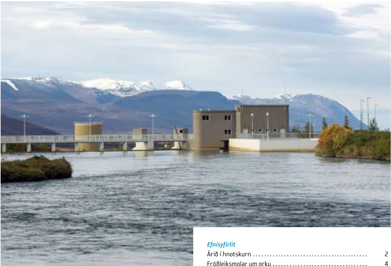
Inntakslón Laxárdvöðvar II. Stíflumannvirkin voru byggð árið 1952.
