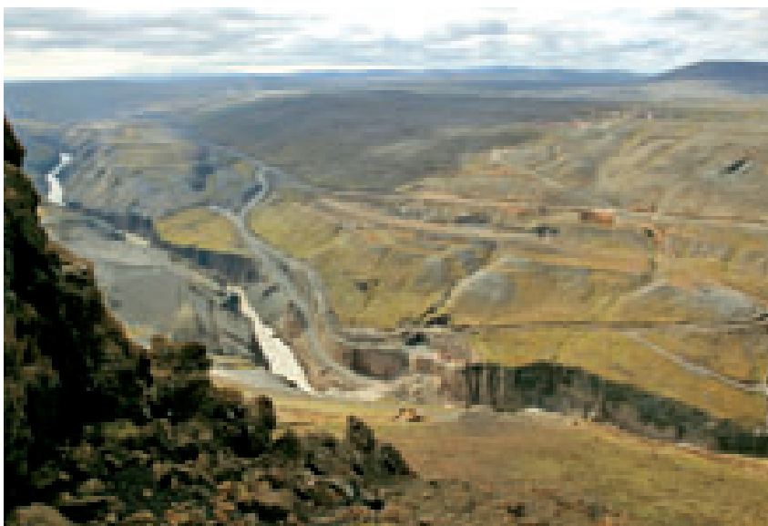
Litið yfir vinnsvæði Kárahnjúkastíflu 2003
