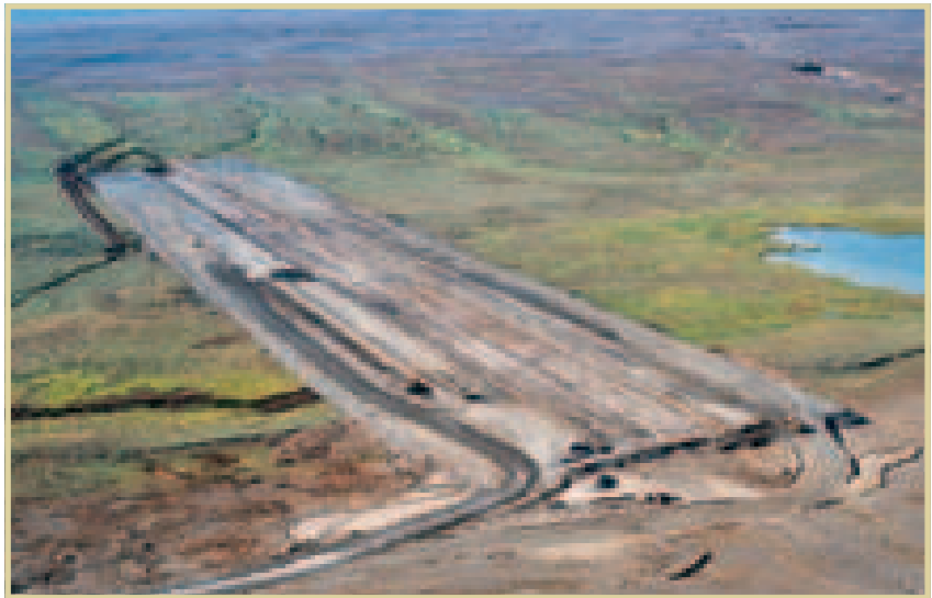
Þann 24. febrúar var undirritaður samningur við lægstbjóðanda, Suðurverk hf, um byggingu Desjarástíflu og Sauðárdalsstíflu (á myndinni). Framkvæmdir á verkstað hófust í apríl og gengu vel og að mestu í samræmi við áætlanir á árinu.
