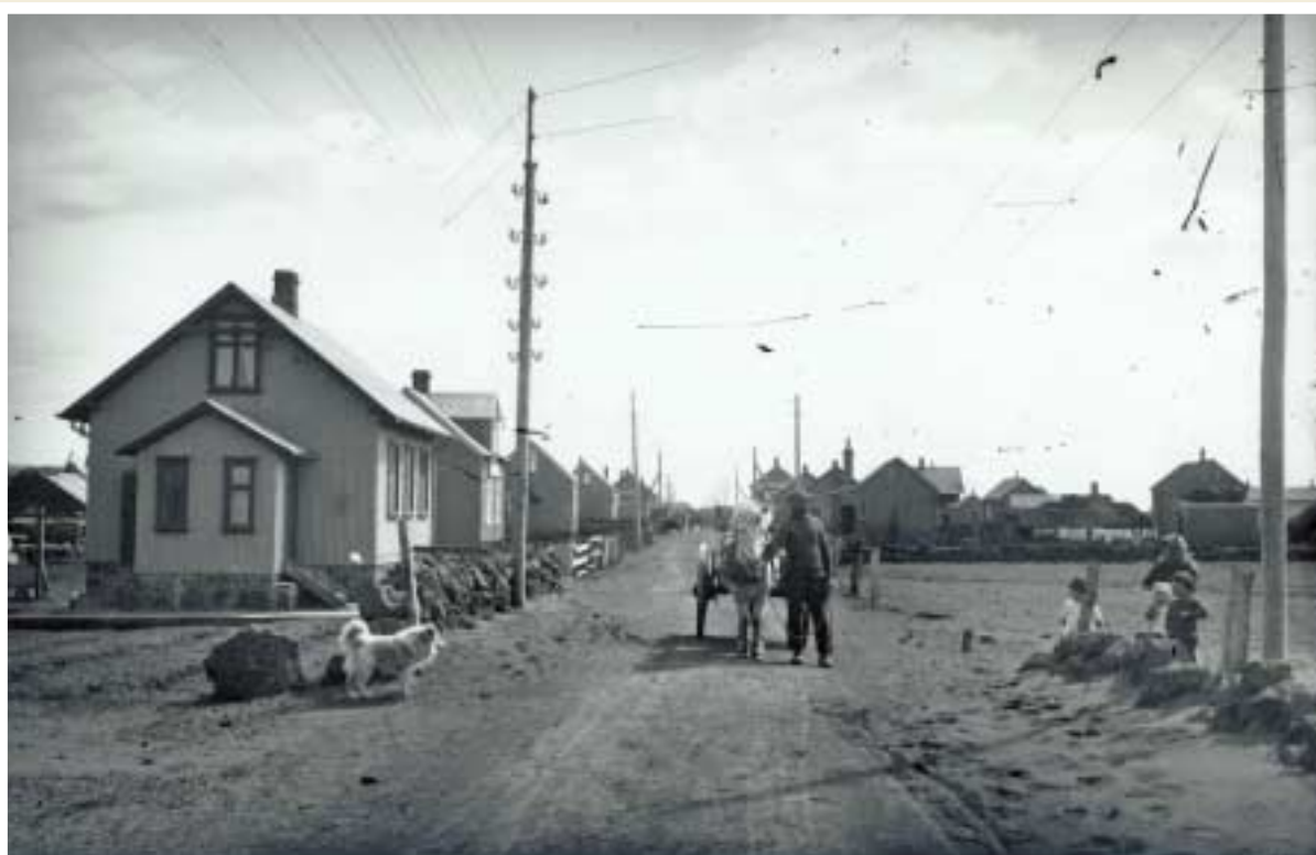
Rafstöðin tekin til starfa á Eyrbakka um 1920. Símastaurar hafa verið hækkaðir til að leggja raflínur í húsín. Ljósmynd Haraldur Blöndal.
