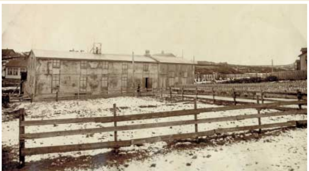
Trésmiðjan Dvergur í Hafnarfirði. Þar kom Jóhannes Reykdal upp fyrstu rafstöð á Íslandi 1904. Sér í vatnsstokk stöðvarinnar hægra megin á myndinni. Ljósmynd Pétur Brynjólfsson.
