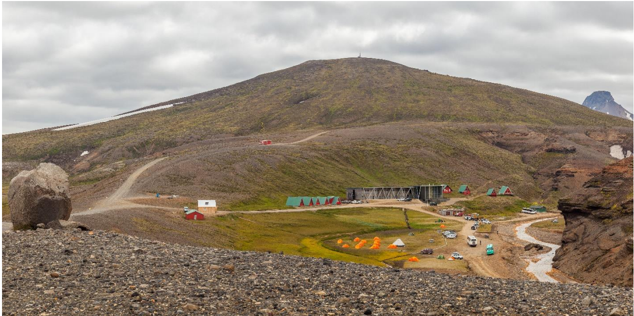
Mynd 13. Valkostur 2. Lokið hefur verið við 1. áfanga nýbyggingar hálandismiðstöðvar í Ásgarði.
