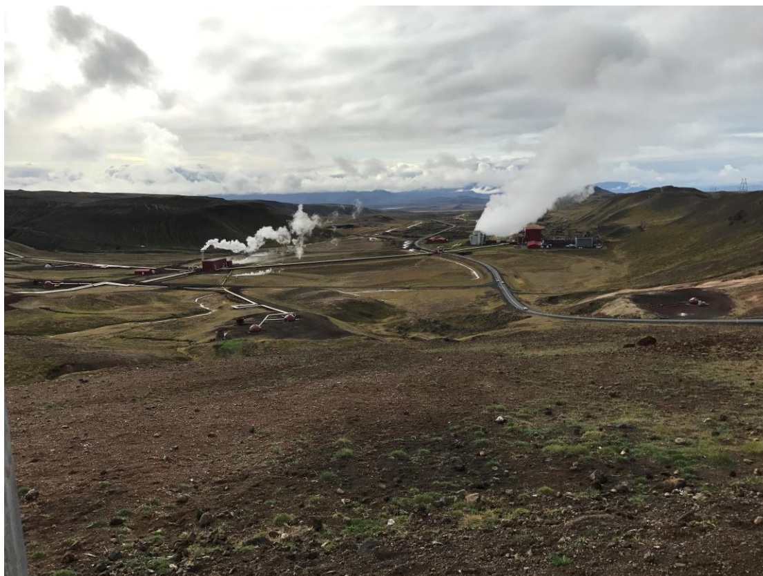
Mynd 3: Horft til suðurs frá útsýnisplani og yfir virkjunarmannvirki á Kröflusvæðinu
