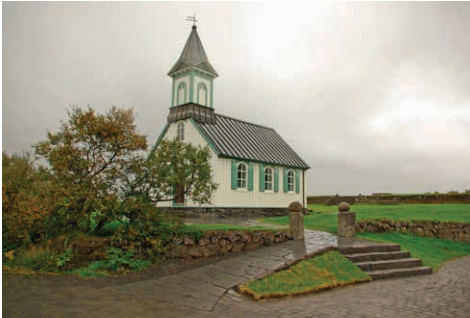
Umhverfi Þingvallakirkju að loknum framkvæmdum 2010.
