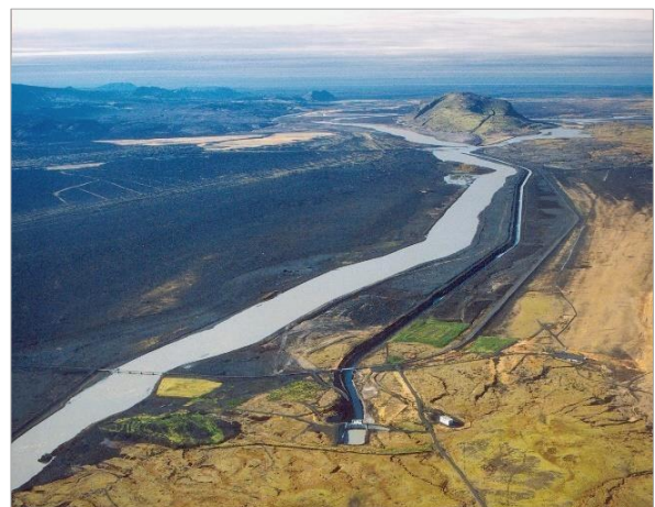
Mynd 8. Horft í átt að Búrfelli yfir Sultartangavirkjun og frárennisskurð hennar. Þjórsá t.v. (Mynd: Emil Þór Sigurðsson).
