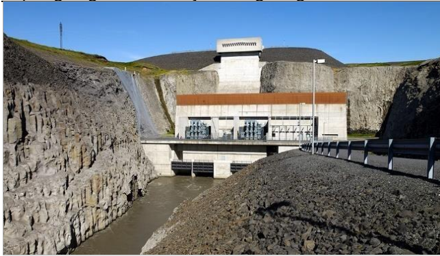
Mynd 6. Stöðvarhús Sultartangavirkjunar. (Mynd: Landsvirkjun).
