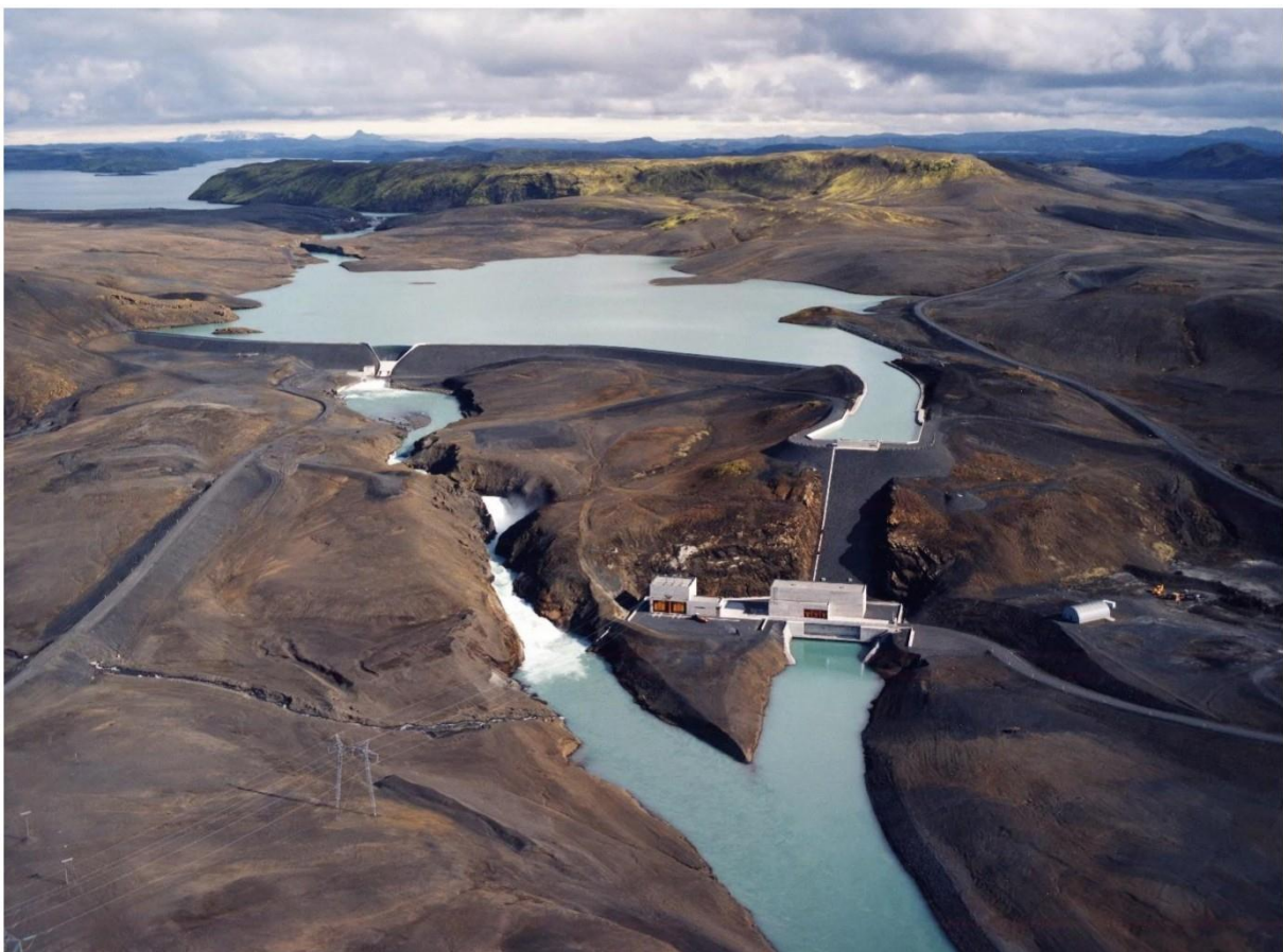
Mynd 18. Vatnsfellsvirkjun og Vatnsfellslón. Þórisvatn fjær. (Mynd: Emil Þór Sigurðsson).
