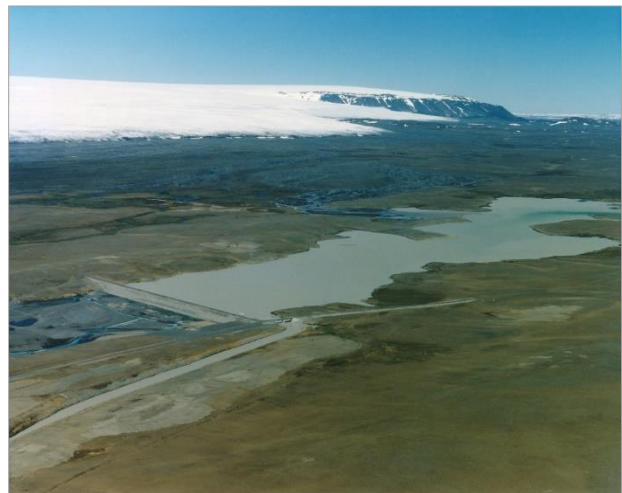
Mynd 27. Úr Þjórsárlóni er nyrstu kvíslum Þjórsár veitt um skurð í Kvislaveitu. (Mynd: Emil Þór Sigurðsson).
