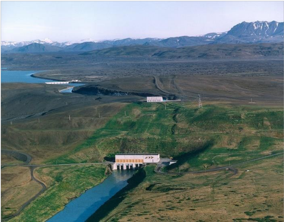
Mynd 13. Stöðvarhús, inntak og frárennisskurður Hrauneyjafossvirkjunar, sér í Hrauneyjalón ofar. (Mynd: Emil Þór Sigurðsson).
