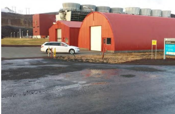
Mynd 8 Aðkoma að stöðvarbyggingu - 04.11.2016 ÁT Skilti hjálpa en gera mætti aðkomu að stöðvarbyggingu og gestastofu Kröflustöðvar þannig úr garði að greinilegt sé að hér er um aðalaðkomu að ræða
