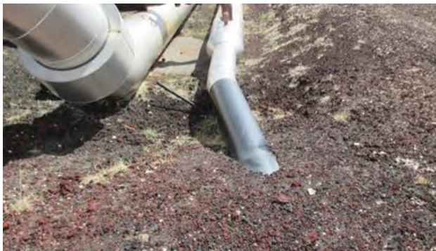
Mynd 29 Borplan K - áberandi rörendar - 19.06.2015 ÁT Fylla yfir svartan röraenda.
