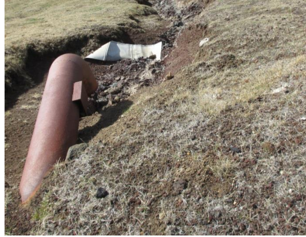
Mynd 33 Borplan L - áberandi afrennslisrör og rof - 10.06.2016 ÁT
