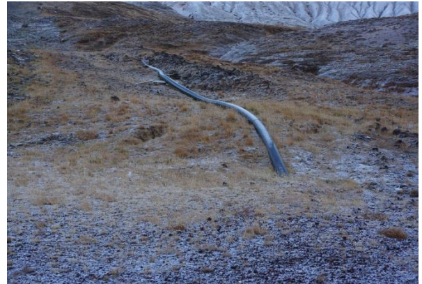
Mynd 28 Borplan K - rör ofanjarðar - 19.06.2015 ÁT Grafa þarf niður rör og ganga frá endanlega.
