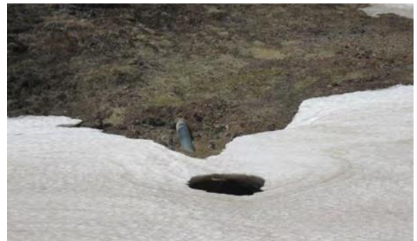
Mynd 30 Borplan K - jarðvegur hefur rofnað - 19.06.2015 ÁT Fylla yfir rör þar sem jarðvegur hefur rofnað.
