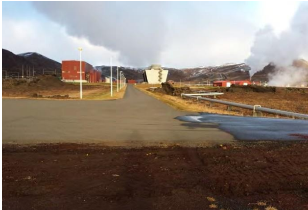
Mynd 6 Stöðvarbygging og kæliturn - 04.11.2016 ÁT Horft frá starfsmannahúsi. Grár gafl kæliturns áberandi
