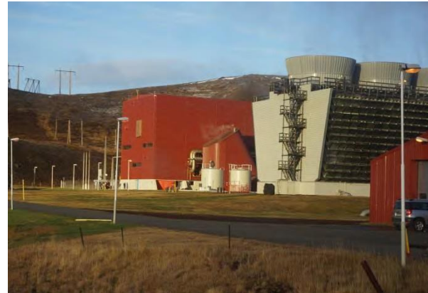
Mynd 7 Stöðvarbygging og kæliturn - 04.11.2016 ÁT Samræma mætti byggingar með rauðum lit á gafl kæliturns.
