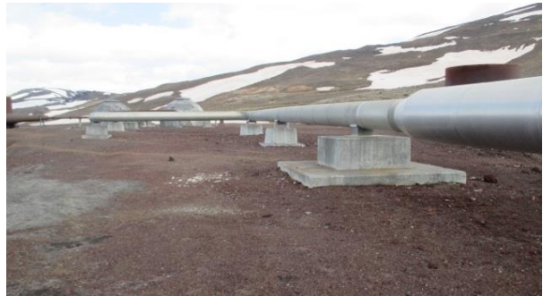
Mynd 21 Borplan C við Víti - steiptir sökkjar - 19.06.2015 ÁT Fylla þarf betur að steiptum sökkjum
