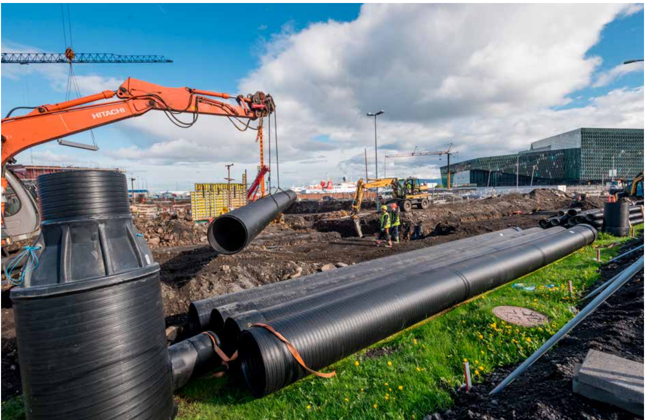
Framkvæmdir í miðborg Reykjavíkur. Weholite lagnaefni í forgrunni.
