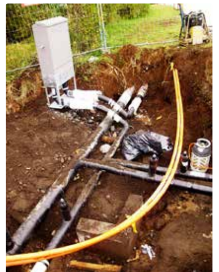
Nýjar tengingar, kranar og dæla sérsmiðaðar af Set.
