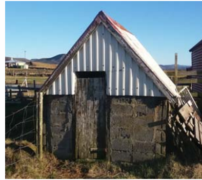
Hús 14 2017, horft til austurs
