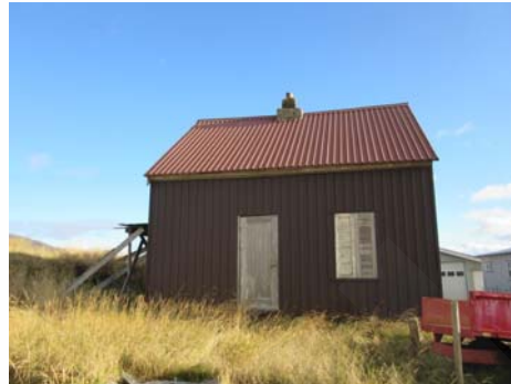
Einland 2017, horft til norðausturs
