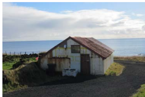
Hús 11 2017, horft til suðurs
