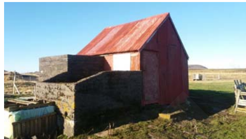
Hús 23 horft til NNV
