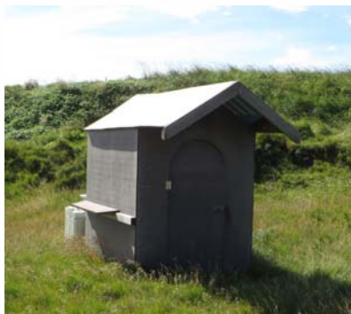
Hús 31 dúkkukofi, 2017 horft til suðvesturs
