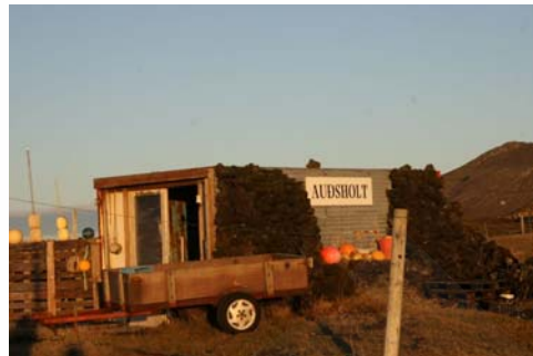
Geymsluskúr við Auðsholt 2017, horft til NNV
