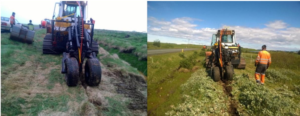
Mynd 4.8 Plæging á 11 kV rafstreng í jarðveg og gras vinstra megin og jarðveg og víðigróður hægra megin. Á myndunum sjást ummerki beint í kjölfar plægingar.
