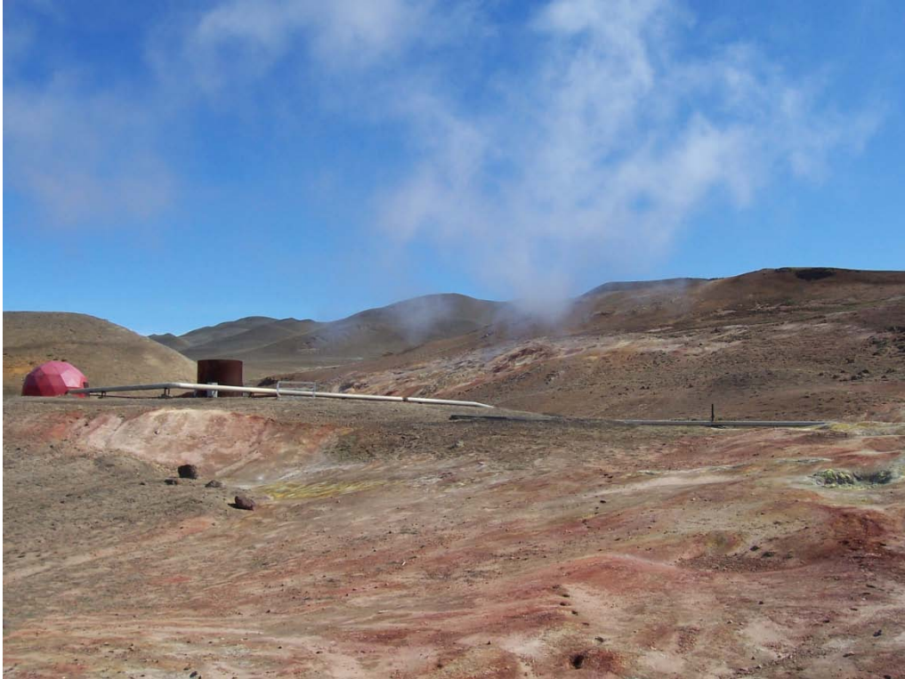
MYND 15. Séð af brúnni yfir gufulögnina á Gufustöðvarveginum yfir að BN-9 upp í dalverpið.
