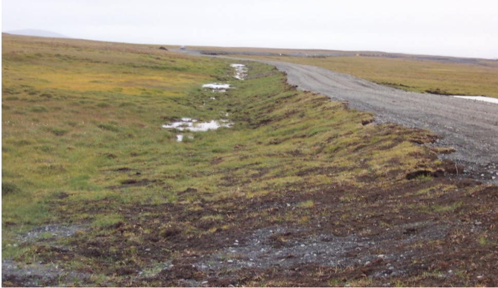
Mynd 13 Hálsvegur. Vegfláinn sem snýr frá lóninu er víða þegar gróinn náttúrulegum gróðri en torf úr vegstæðinu var lagt á bakkann.
