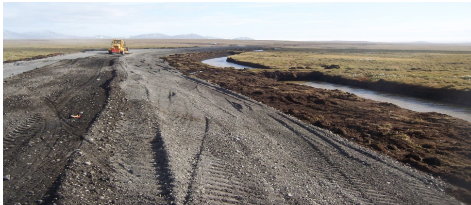
Mynd 14 Vegfláinn sem snýr að lóninu. Neðan hans eru gryfjurnar sem taka eiga við áfoki.
