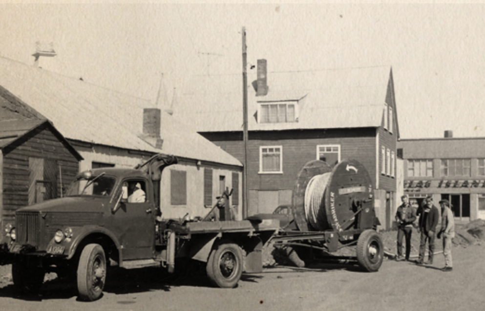
Starfsmenn Rafveitu Akureyrar draga út streng sunnan við þar sem núna er Bautinn.
