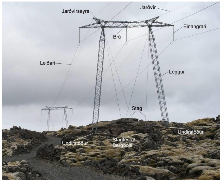
Mynd 3 Stagað M-mastur úr Búrfellslínu 3B (220 kV). Skýring á helstu hugtökum.
