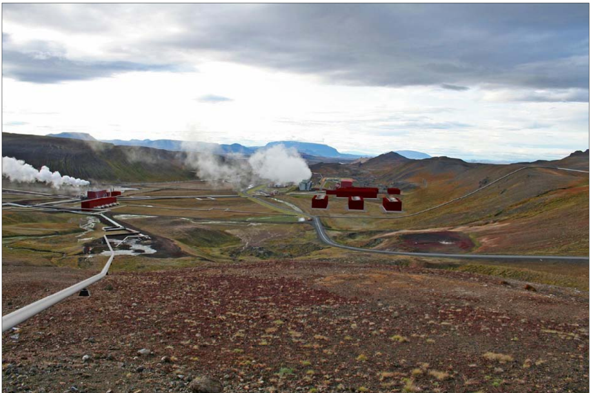
Mynd 9.34 Ásjón frá útsýnispalli, norðan Kröflustöðvar með tilkomu Kröfluvirkjunar II. Kæliturnar nýju virkjunarinnar eru sýndir án gufu til að skyggja ekki á önnur virkjunarmannvirki.
