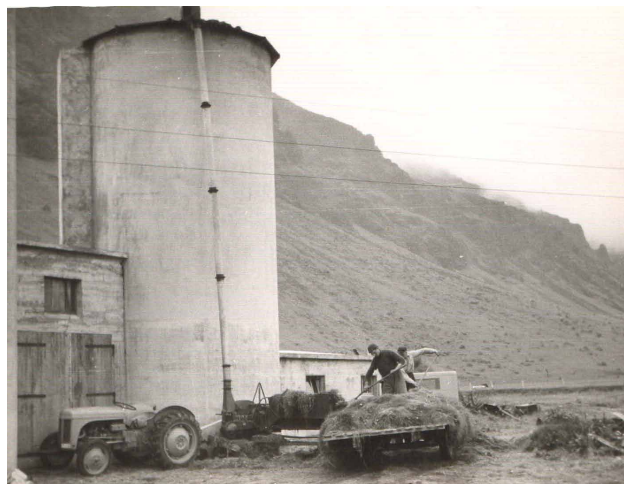
Mynd 9.1 Um og upp úr miðri síðustu öld voru steinsteyptir votheysturnar algengir. Heyinu var ýmist blásið upp í þá, eins og hér má sjá, eða það flutt með færibaldi.. Myndin er frá Þorvaldseyri. (Ólafur Guðmundsson).
