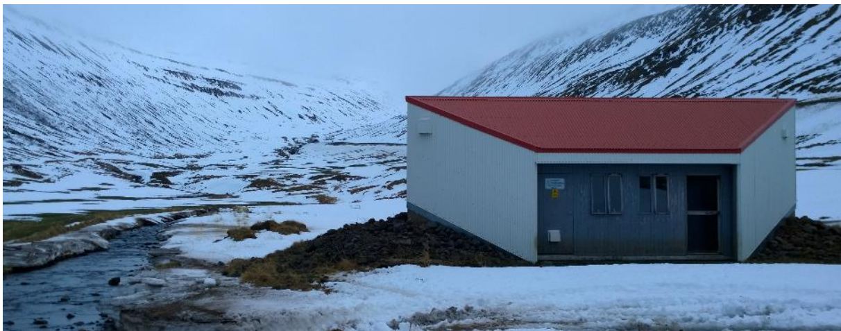
Mynd 14 Stöðvarhús Dalsorku (Ljósmynd: Dalsorka ehf.)
