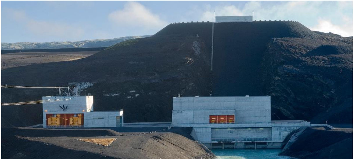
Mynd 60 Vatnsfellsvirkjun (Ljósmynd: LV)
