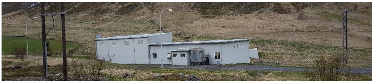
Mynd 42 Nónhornsvatnsvirkjun - Rafstöðin að Fossum (Ljósmynd: OV)
