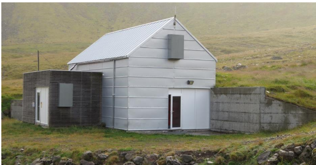
Mynd 29 Stöðvarhús fyrir vélar Hvestuárvirkjunar og Þverárvirkjunar (Hvestuveita ehf.)
