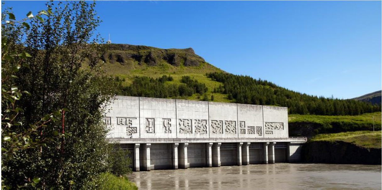
Mynd 13 Stöðvarhús Búfellsvirkjunar (Ljósmynd: LV)
