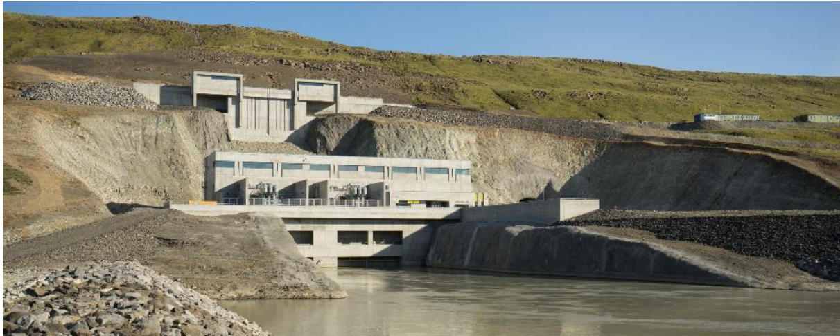
Mynd 12 Stöðvarhús Búðarhálsvirkjun (Ljósmynd: LV)
