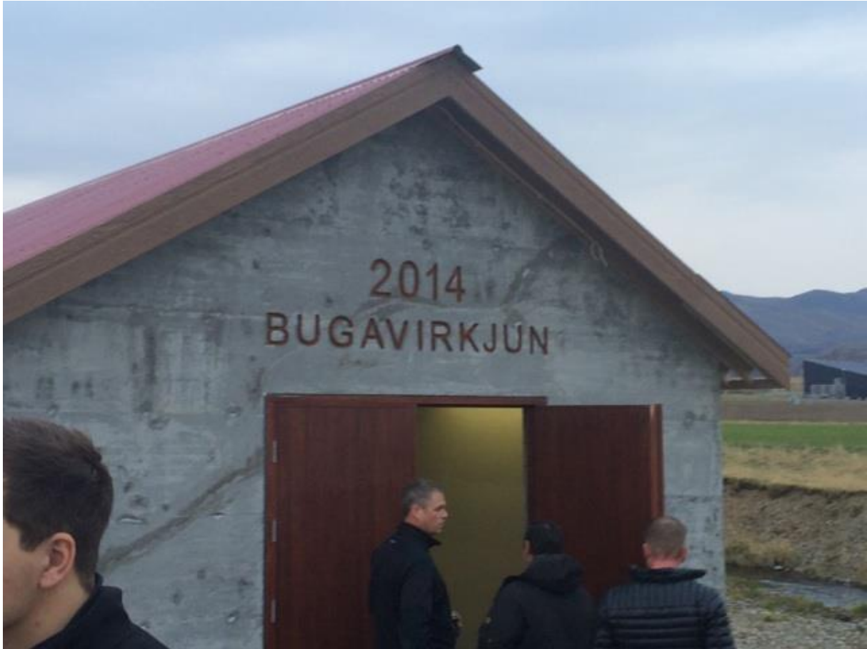
Mynd 10 Stöðvarhús Bugavirkjunar (Ljósmynd: Bugavirkjun ehf.)
