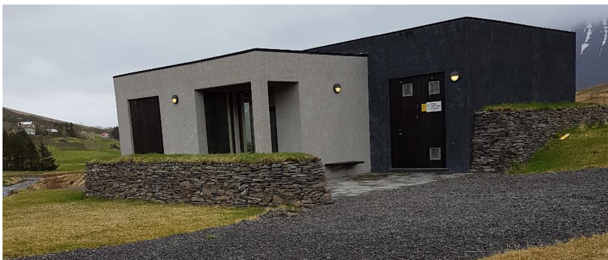
Mynd 59 Tungudalsvirkjun (Ljósmynd: Arnarós hf.)
