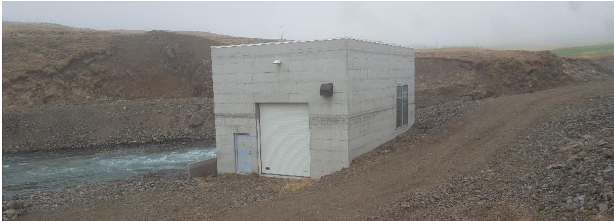
Mynd 16 Stöðvarhús Djúpadalsvirkjunar II (Ljósmynd: Fallorka)
