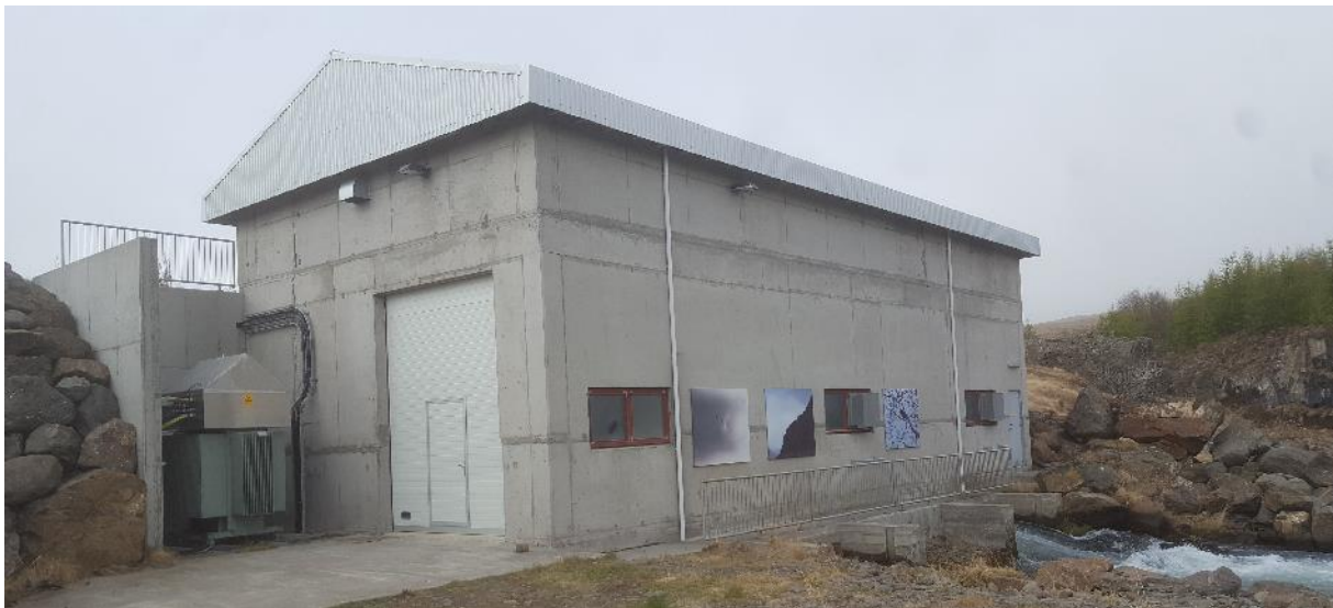
Mynd 15 Stöðvarhús Djúpadalsvirkjunar I (Ljósmynd: Fallorka)
