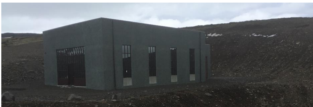
Mynd 23 Gúlsvirkjun (Ljósmynd: ÍO)
