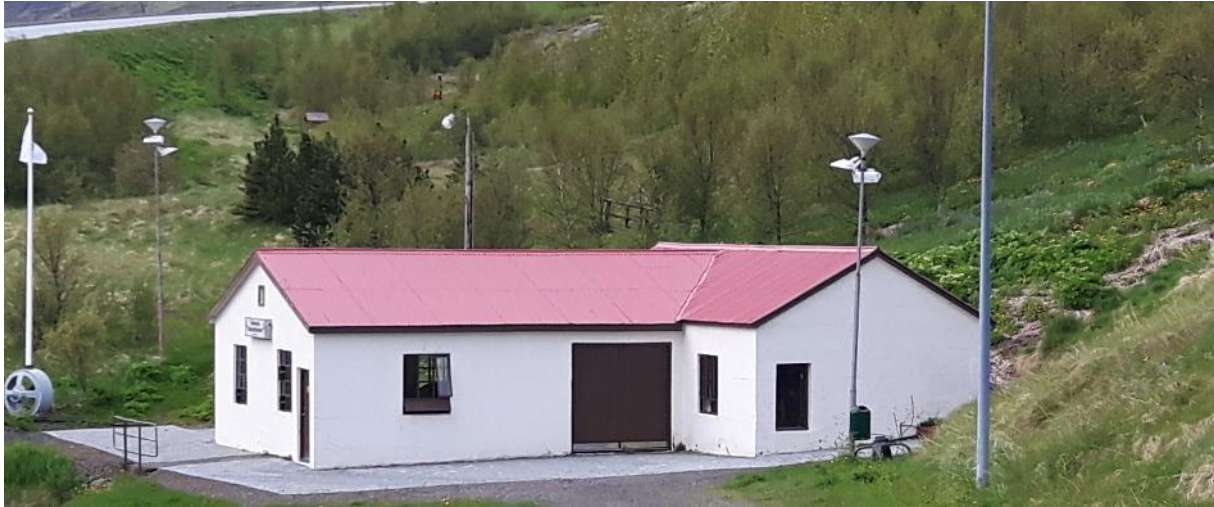
Mynd 11 Stöðvarhús Búðarvirkjunar (Ljósmynd: Rafveita Reyðarfjarðar)
