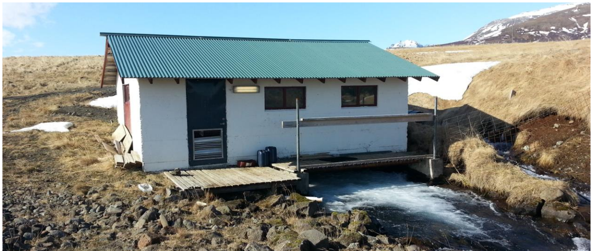
Mynd 47 Sandárvirkjun IV (Ljósmynd: Eyvindartunga ehf.)
