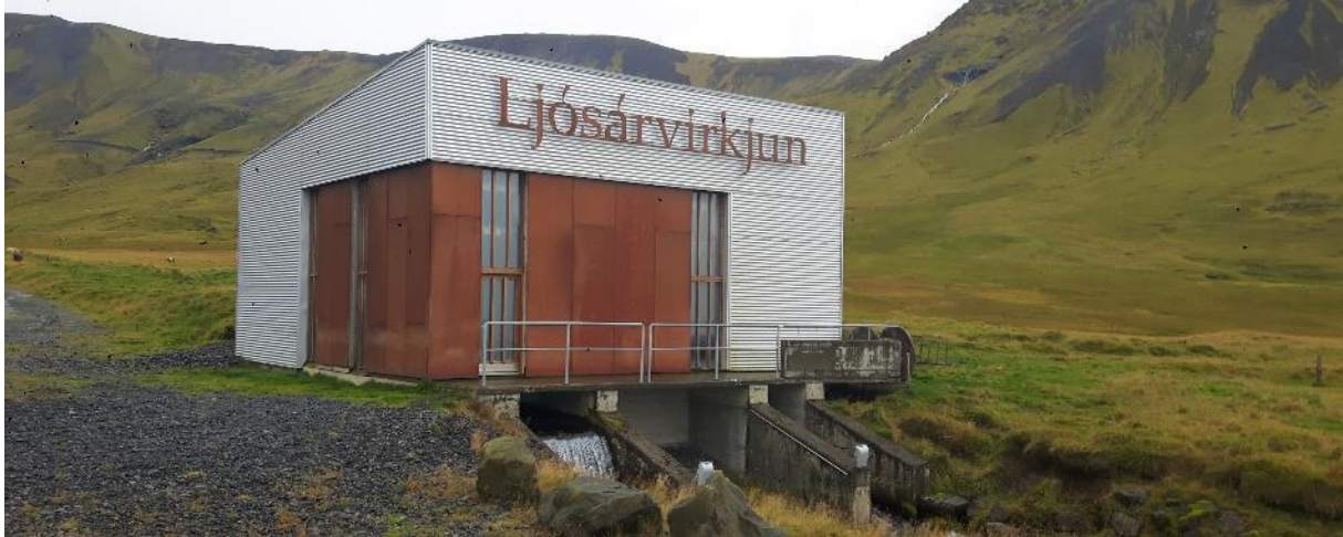
Mynd 36 Ljósárvirkjun - Ljósárvirkjun I og II eru í sama húsi (Ljósmynd: Ljósárvirkjun)
