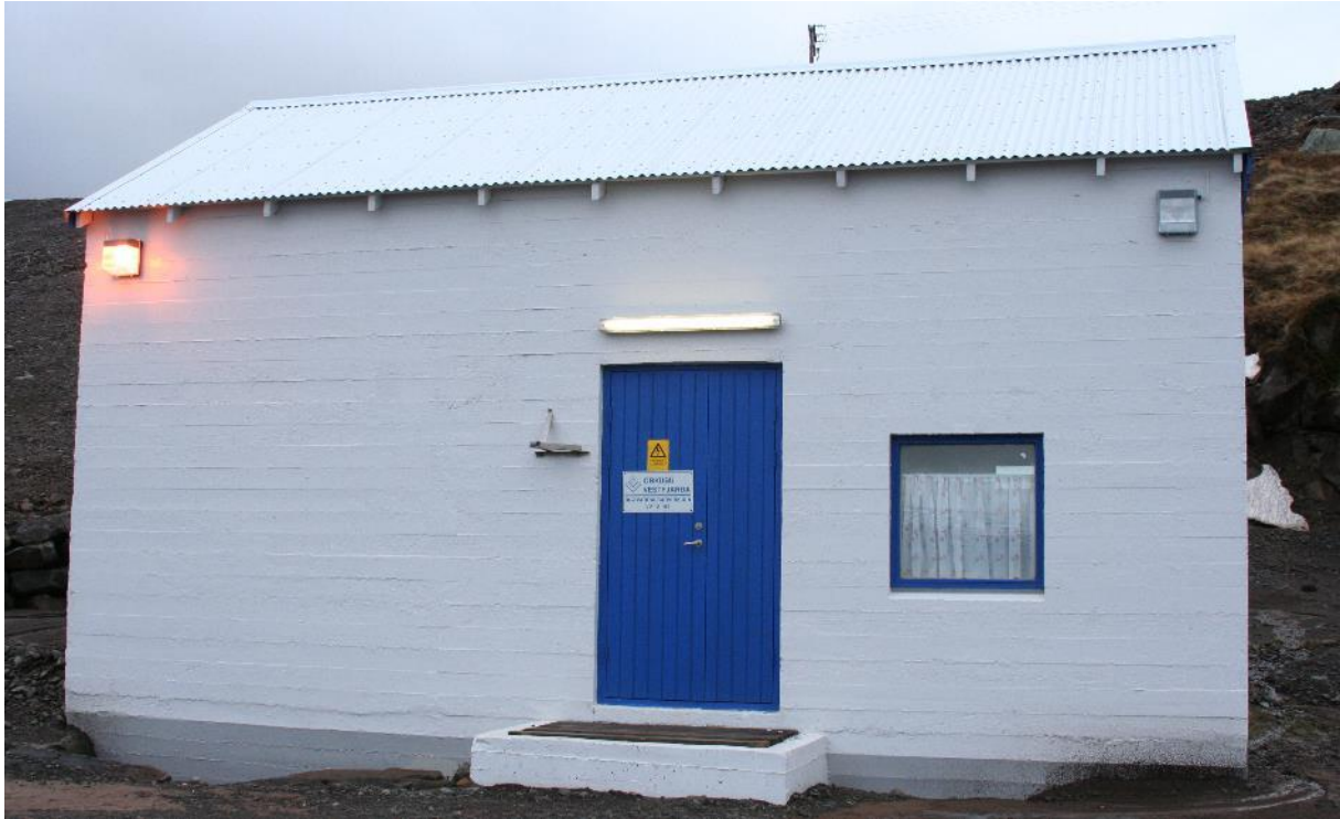
Mynd 8 Stöðvarhús Blævardalsárvirkjunar (Ljósmynd: OV)
