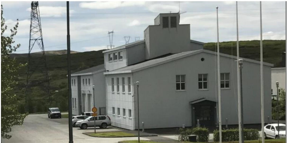
Mynd 51 Írafossstöð (Ljósmynd: LV)
