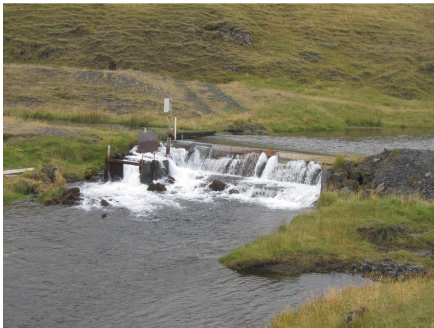
8. mynd. Rafstöðvarstífla í Grenlæk í Skaftárhreppi. Hluti lækjarins er leiddur um skurð til inntakslóns virkjunar. Fiskstigi er í stíflunni (vinstra megin) til að greiða leið fiska upp lækinn. Í honum er fiskteljari sem telur fisk á leið upp. Ljósmynd Magnús Jóhannsson.
