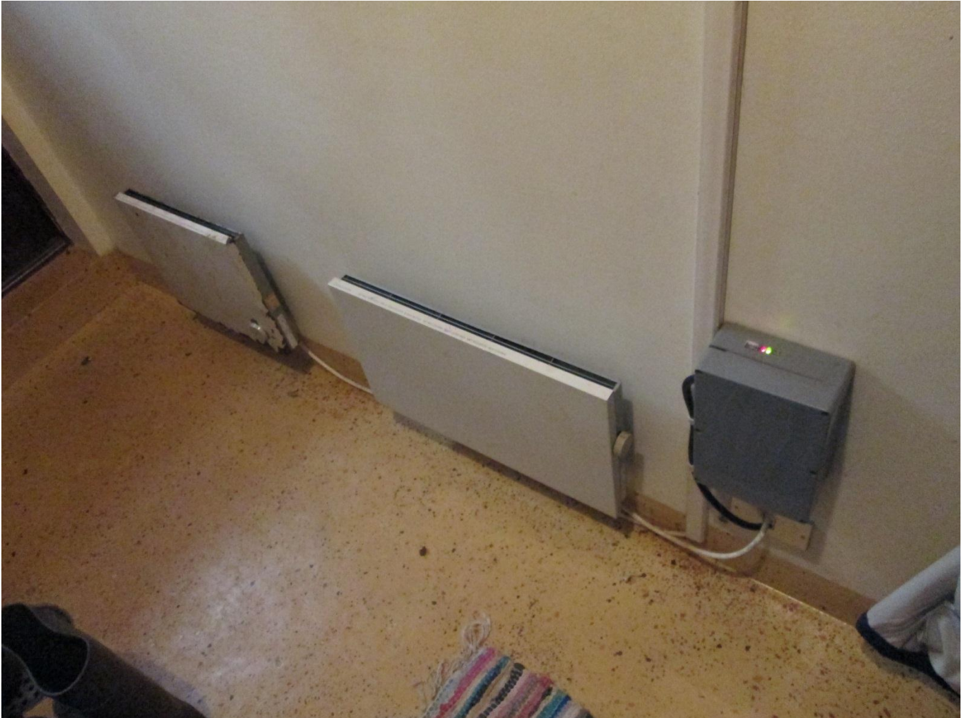
Myndin sýnir álagsstýringuna í gráa boxinu hægra megin á myndinni og 2 af ofnunum sem tengdir eru við hana.
