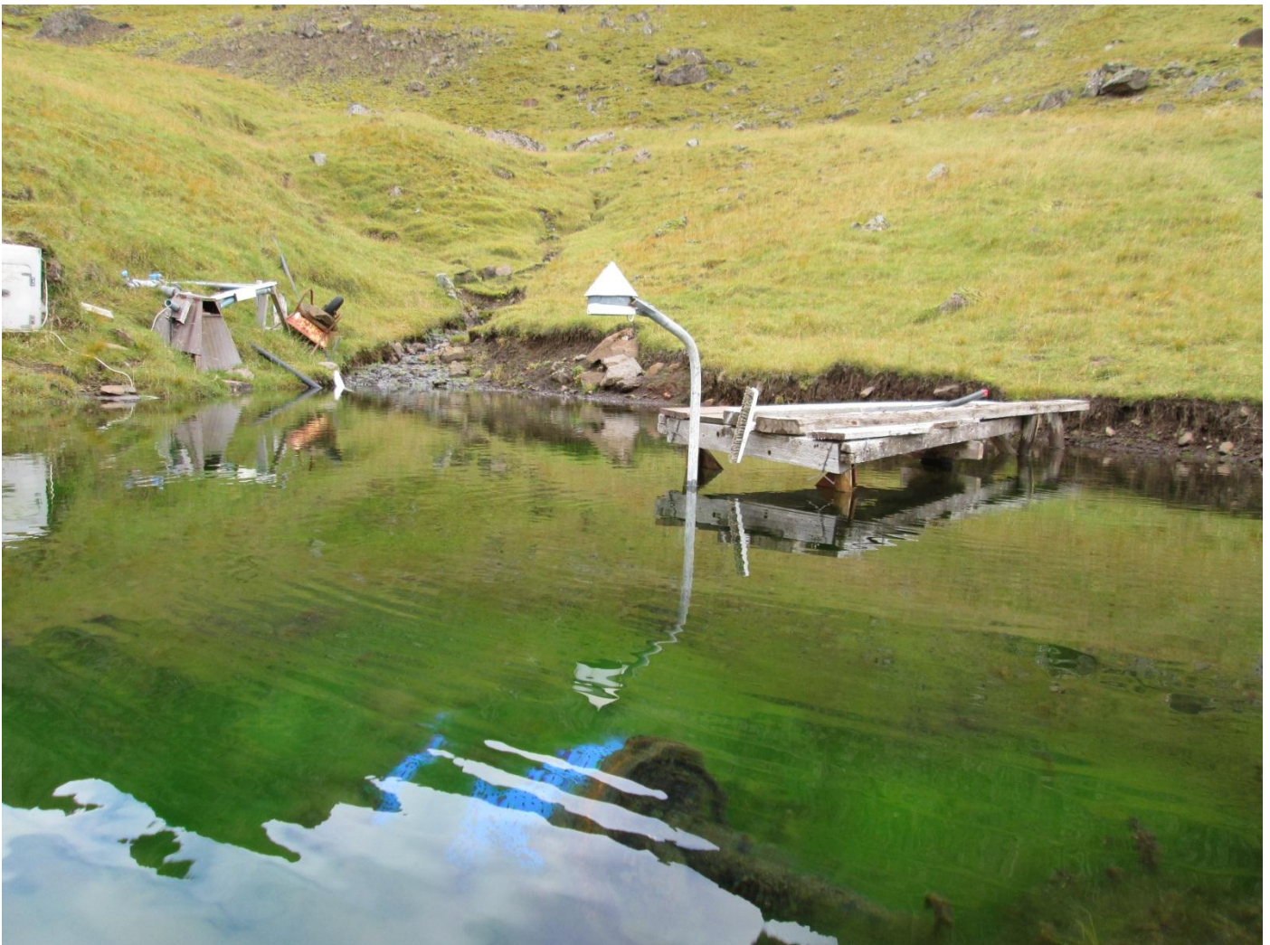
Fyrir miðri mynd sést síldartunna sem notuð er sem sigti/sía á endann á þrýstipípunni, aðeins lengra út í lóninu sést svo hæðarmælirinn og bryggja sem smíðuð var til að geta annast viðhald á mælinum án þess að þurfa að tæma lónið.
