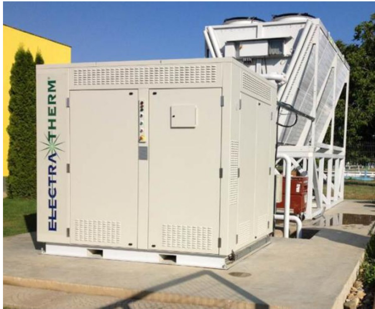
Mynd 10: Tvenndarvél frá ElectraTherm sem kallast Green Machine. Myndin er tekin í Rúmeníu í desember 2012 þar sem jarðhiti er nýttur til raforkuframleiðslu. Á Hveravöllum yrði sennilega vatnskæling og ekki þarf þá að nota loftkæliturn eins og þann sem sýndur er á myndinni aftan við vélargáminn.
