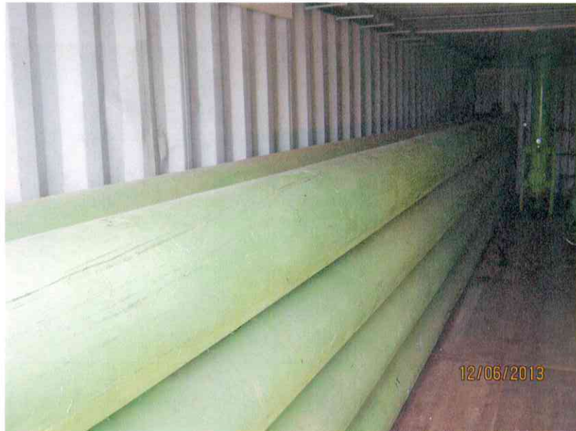
Mynd 6: Gas er geymt á lágþrýstikútum í gasstöðinni. Alls eru 8 kútar, 11 metrar á lengd, sem geyma gas tilbúið til áfyllingar
