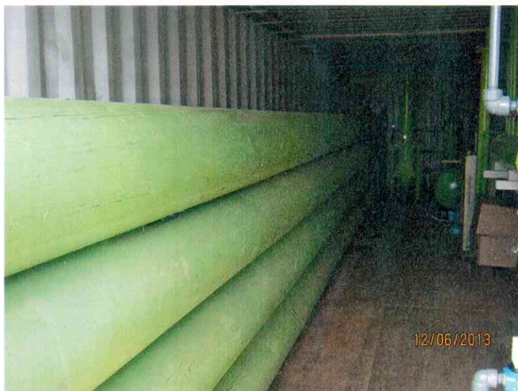
Mynd 6: Lágþrýstilager er í gasvinnslugámnum. Liggjandi rör sitja endilangt meðfram langhliðgámsins. Rörin eru 8 talsins og geta geymt alls 20 Nm 3 af gasi.
