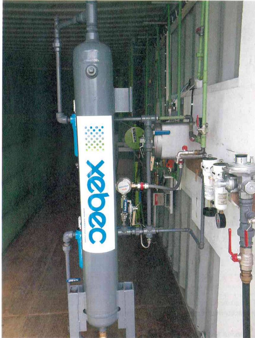
Mynd 19: Hér má sjá eftirþurrkarann sem settur var upp snemma árs 2013. Þurrkarinn er frá Xebec og vinnur raka úr gasi þegar það kemur frá lágþrýstilager á leið að áfyllingarstöð.
