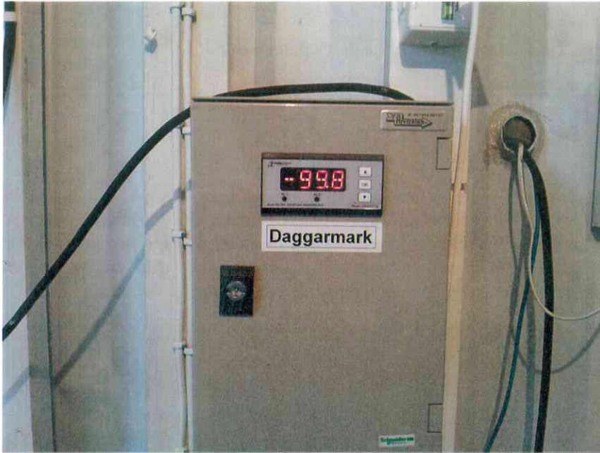
Mynd 18: Eftir notkun í 1-2 daga nær forþurrkarinn að ná daggarmarki niður fyrir -100^{\circ}\text{C} . Hér sýnir mælirinn -99,8^{\circ}\text{C} .
