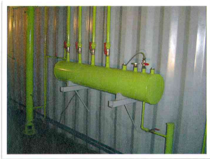
Mynd 2: Hauggas- tengigrind í gasvinnslugámi
