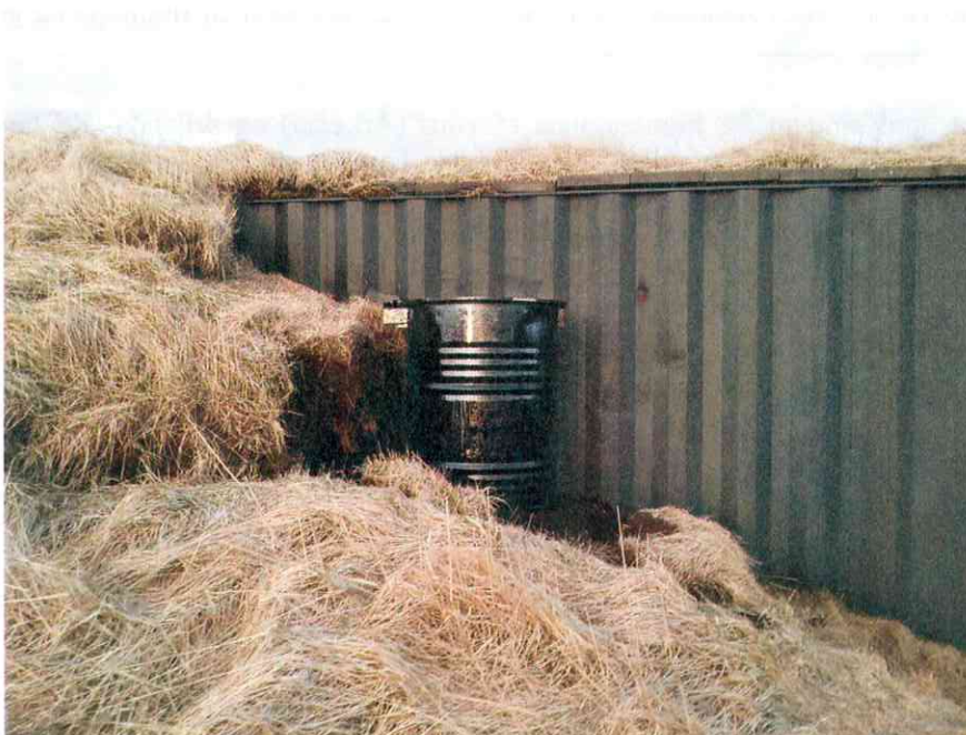
Mynd 23: Lyktarefnið er geymt í læstri tunnu fyrir utan vinnslugáminn. Lögn leiðir lyktarefnið inn í gáminn.
