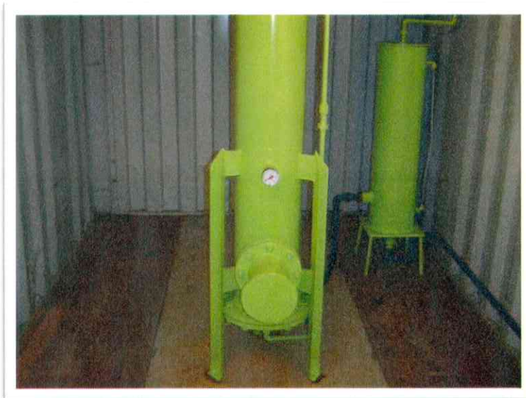
Mynd 3: Þvottaturninn er 8 m hár. Óhreinsað gasið frá pressu er leitt inn í botninn á turninum. Hreinsað gasið er tekið úr toppi turnsins og leitt að þurrkara.
