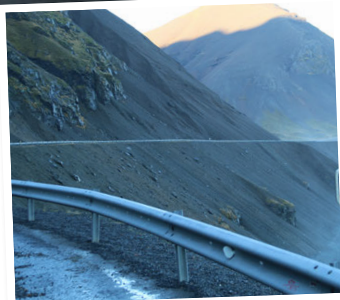
Vegrið við veginn um Hvalnesskriður er alls ekki óásættanlegt. Stærri bílar færðu þarna auðveldlega í gegn með skelfilegum afleiðingum.
