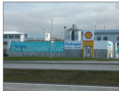
Mynd 4.14 Vetnisstöð sem rafgreinir vatn í vetni og súrefni var opnuð við Grjótháls í í Reykjavík í apríl 2003. Í stöðinni er vetni geymt undir miklum þrýstingi þar til það er fyllt á tanka vetnisökutækja. Hráefnið fyrir vinnsluna er aðeins vatn og rafmagn og við notkun þess í bílum myndast aðeins vatn. Mengun er því engin.
