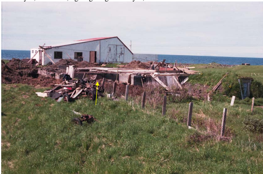
Horft til norðurs heim að húsgrunni bæjarins á Þórustöðum. Skurðurinn sem minjarnar fundust í er í kriknum sunnan við grunninn. (GÓL 9106-01).
