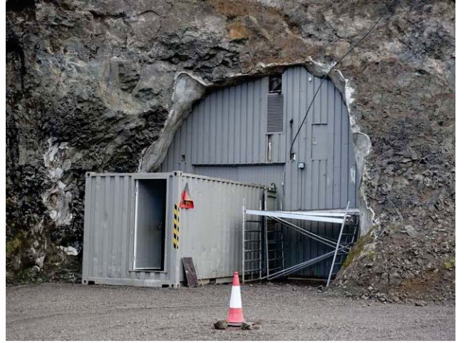
Inngangur að inntaksmannvirki. Bráðabirgðaskýli í forgrunni.
