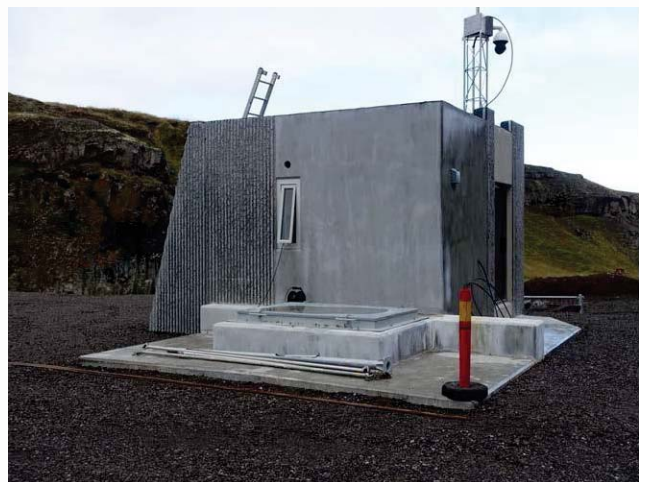
Nýtt lokahús á endurnýjaðri stíflu.
