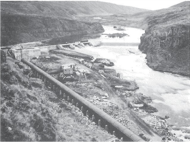
Stíflan og þrýstivatnspípan í upphaflegri mynd.
