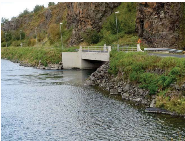
Brú við sográs frá Laxárvirkjun 3.
