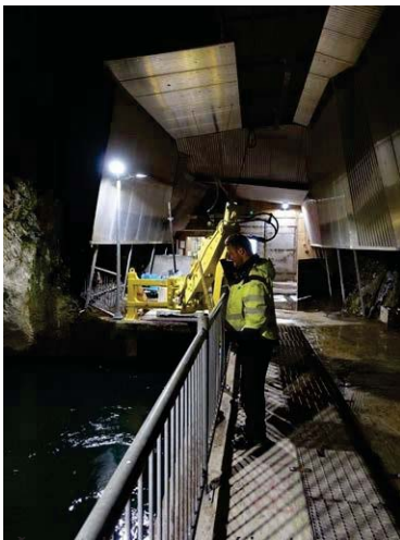
Við munna aðrennslisgangna í inntaksmannvirki.
