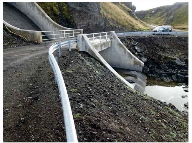
Brú yfir rennu.
