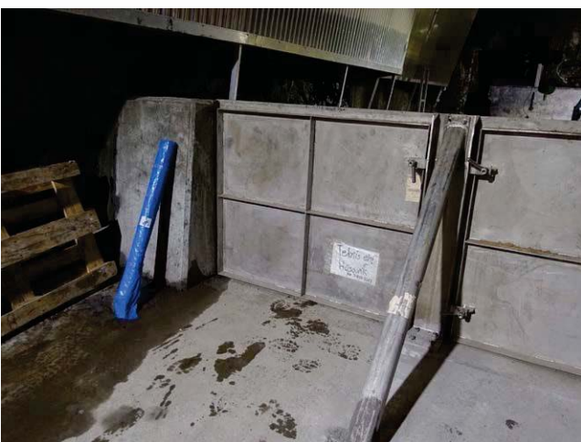
Krapavörn í inntaksmannvirki.
