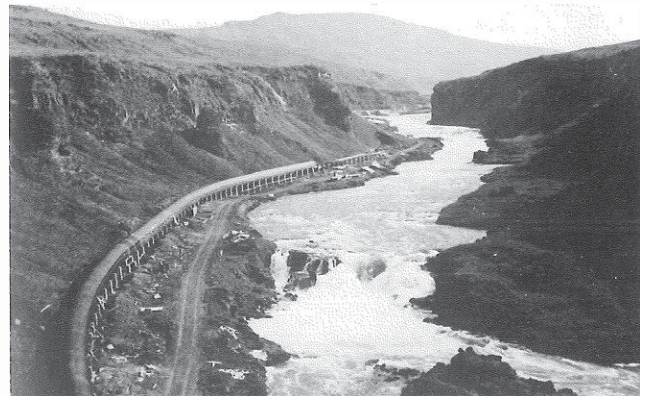
Horft upp eftir Laxárgljúfri. Þrýstivatnspípan í byggingu.
