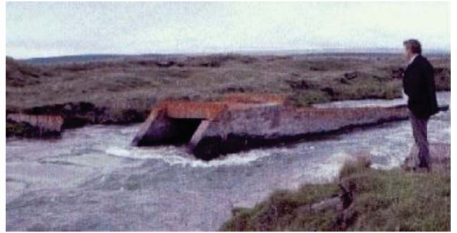
Miðkvíslarstífla eftir sprenginguna.
