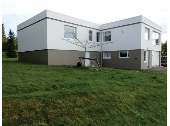
Hús 4, horft úr norðri.
