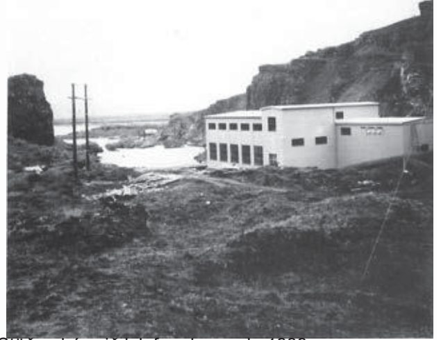
Stöðvarhús við lok framkvæmda 1939.
