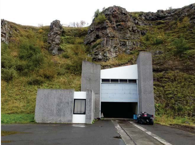
Inngangur í stöðvarhús 3.
