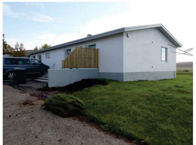
Hús 7, horft úr norðri.
