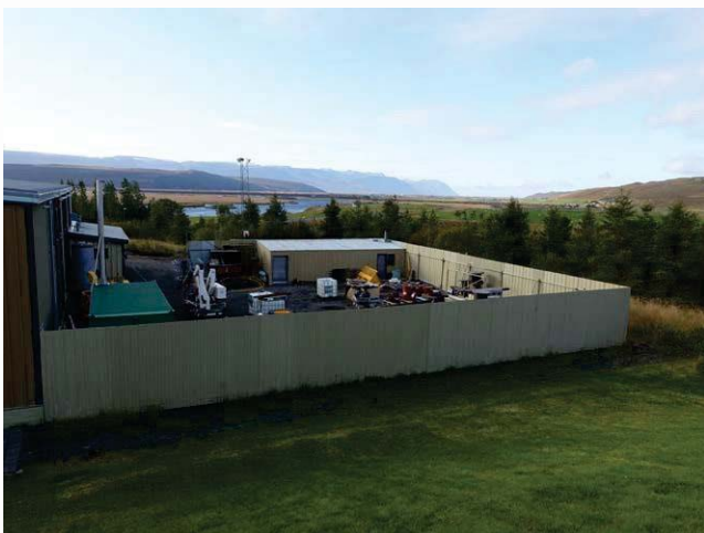
Geymslusvæði norðan verkstæðisbyggingar.
