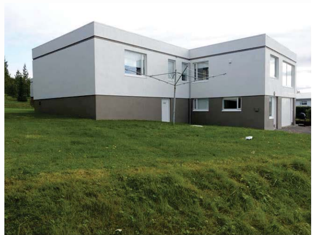
Hús 6, horft úr norðri.
