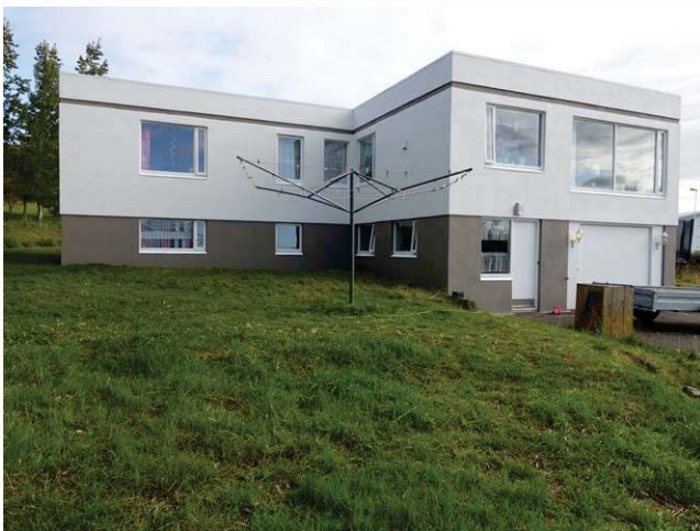
Hús 8, horft úr norðri.
