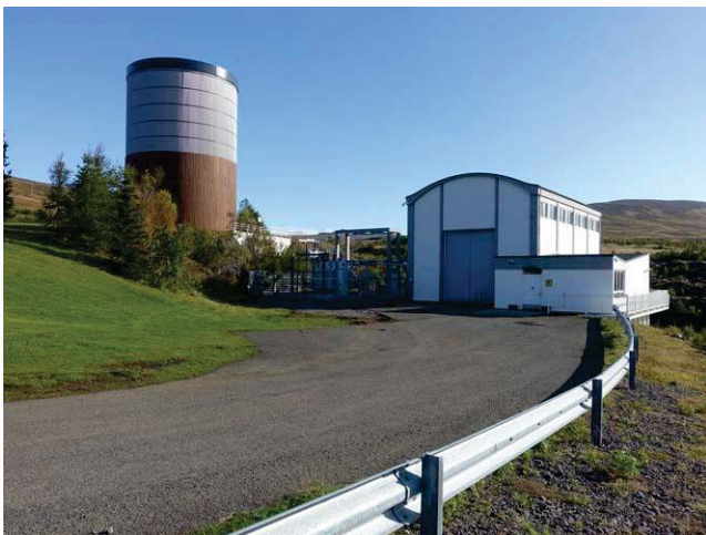
Stöðvarhús 2 úr norðri, þrýstijöfnunarturn í baksýn.
