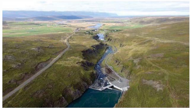
Horft til norðurs niður eftir Laxárgljúfri yfir endurnýjaða stíflu.
