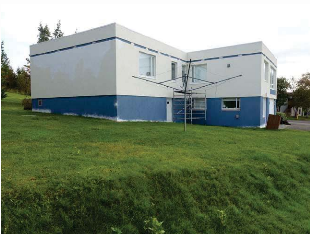
Hús 2, horft úr norðri.
