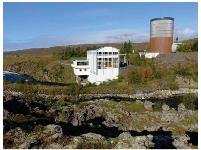
Stöðvarhús Laxárvirkjunar 2 og þrýstivatnsturninn.
