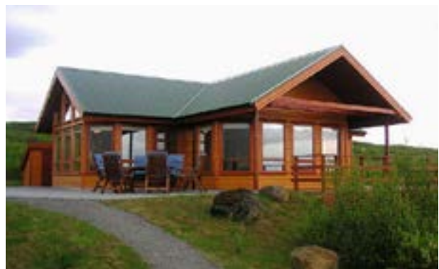
Hús 41, Fagrabrekka. Húsið, sem er D-hús, var vígt sumarið 2007 og var þá stærsta orlofshúsið í Brekkuskógi.
