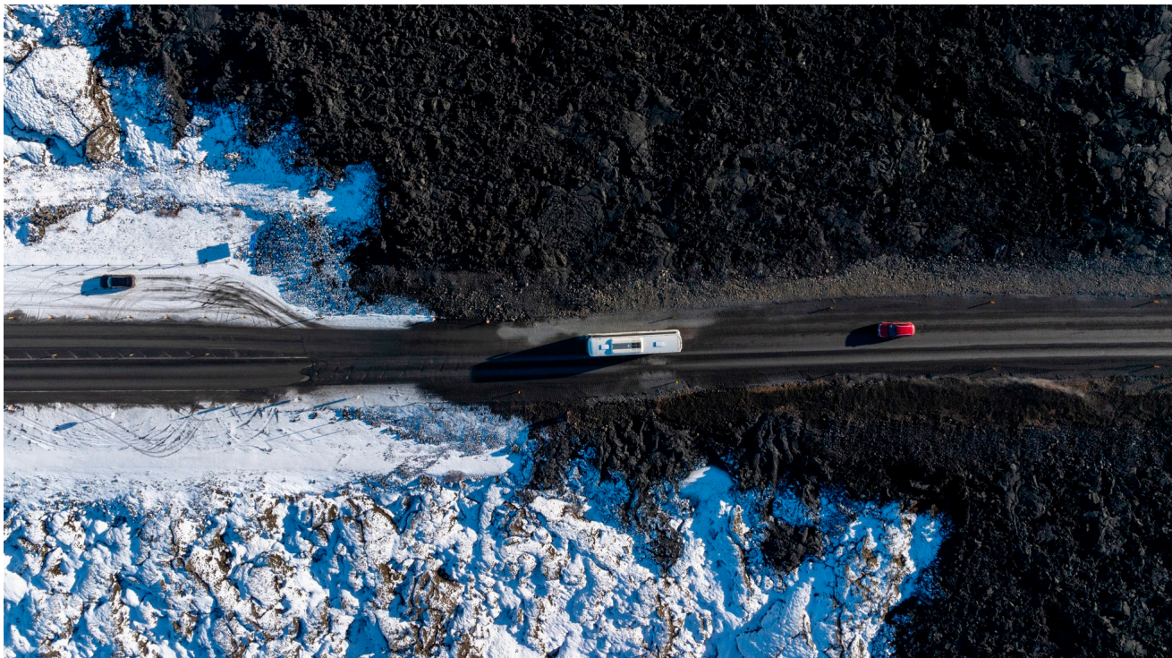
↑ Leggja þurfti veg yfir nýrunnið hraun á Grindavíkurvegi. Mynd: Vilhelm Gunnarsson
