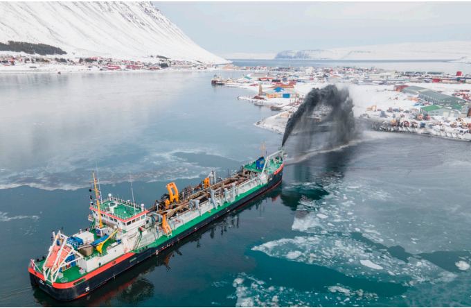
↑ Dýpkunarskipið Hein að störfum á Ísafirði.
