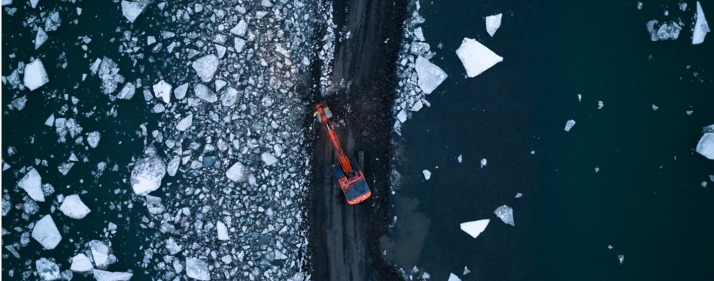
↑ Framkvæmdir við Þorskafjörð í febrúar. Ljósmynd: Haukur Sigurðsson.
