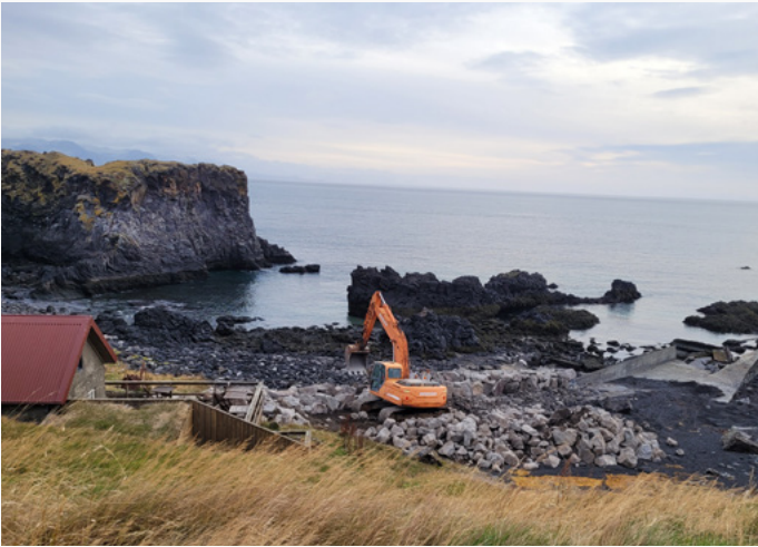
↑ Unnið að sjóvörn við gamla bryggju sem liggur neðan við kaffihús á Hellnum.
