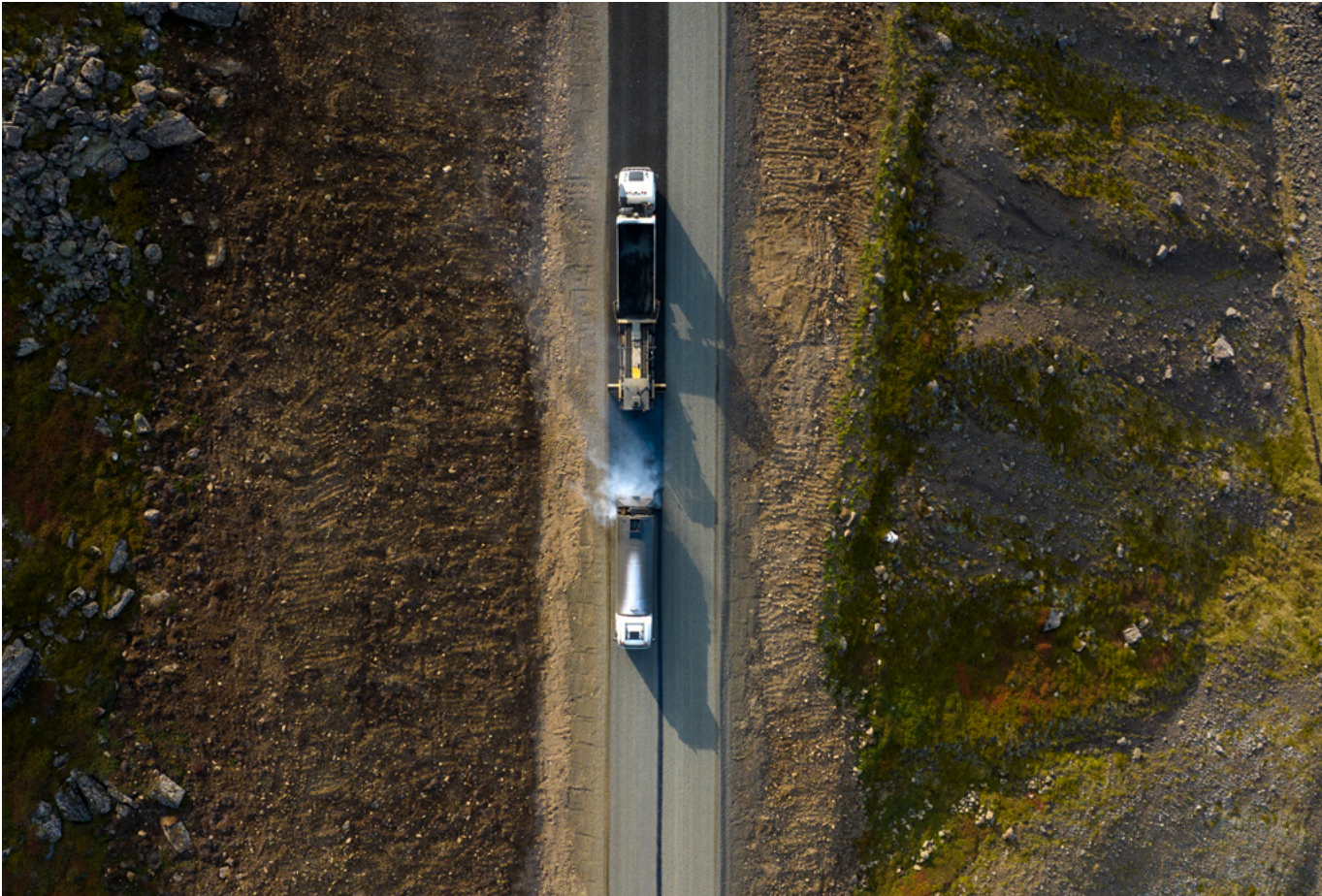
↑ Klæðingaflokkur að störfum á Vestfjarðavegi (60) um Teigsskóg. Ljósmynd: Haukur Sigurðsson.
