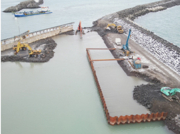
↑ Séð yfir framkvæmdasvæði við Suðurvararbryggju í Þorlákshöfn.
