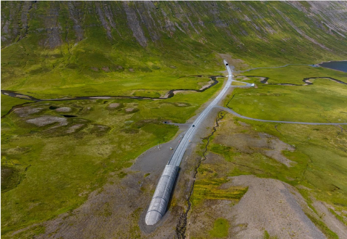
↑ Siglufjarðarvegur (76) í Héðinsfirði, Héðinsfjarðargöng sitt hvoru megin. Ljósmynd: Vilhelm Gunnarsson.
