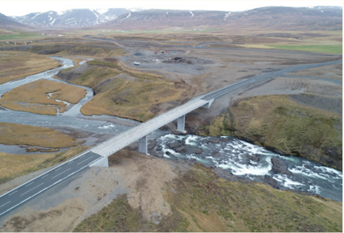
↑ Ný brú yfir Laxá í Refasveit sem var hluti af framkvæmd við nýjan Þverárfjallsveg og Skagastrandarveg.
