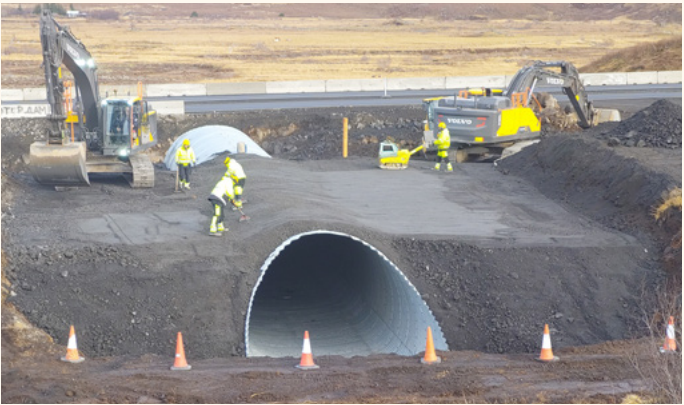
↑ Unnið að breikkun Hringvegjar (1) við Lögbergsbrekku. Hér er verið að ganga frá reiðgöngum undir veginn.
