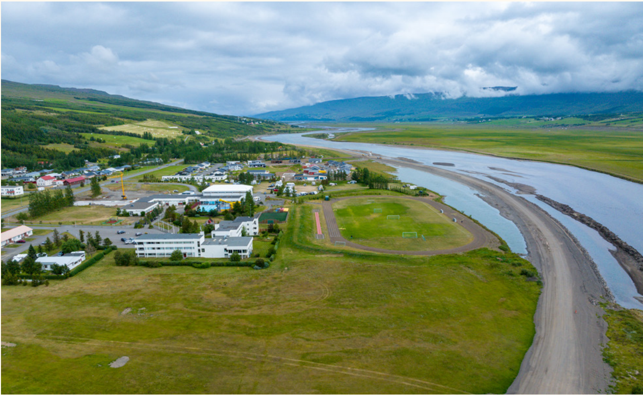
↑ Eyjafjarðarbraut vestri (821) um Hrafnagil. Áætluð verklok júlí 2024.
