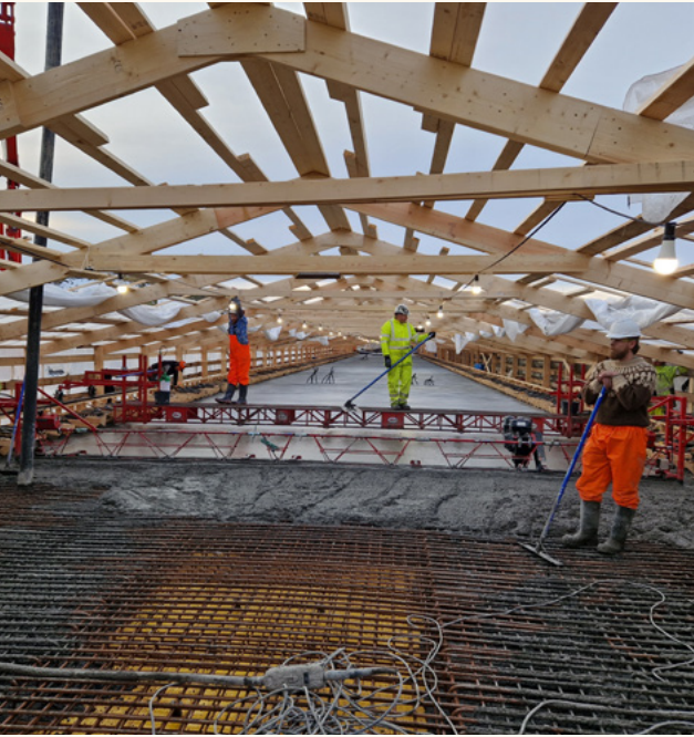
Vegna mikils kuldaveðurs var byggt yfir nýja brú yfir Stóru-Laxá svo hægt væri að steypa brúargólfíð.
