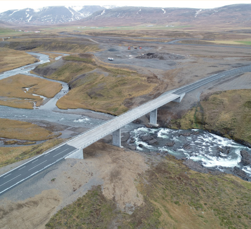
↑ Þverárfjallsvegur (73) í Refasveit og Skagastrandarvegur (74) um Laxá. Verklók nóvember 2023.
