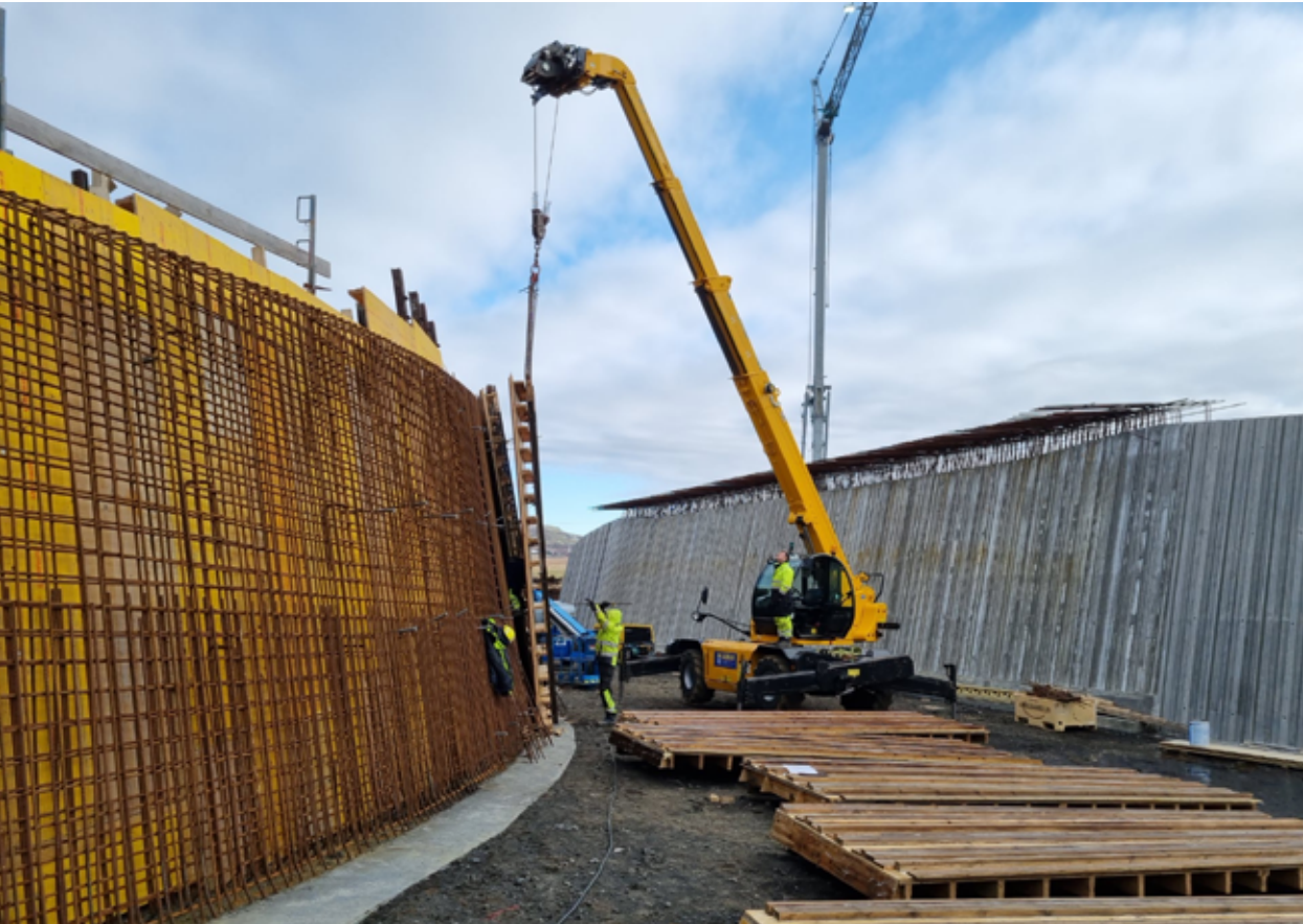
↑ Framkvæmdir við nýja brú og undirgöng við Kotströnd þar sem Ölfusvegur fer undir Suðurlandsveg.
