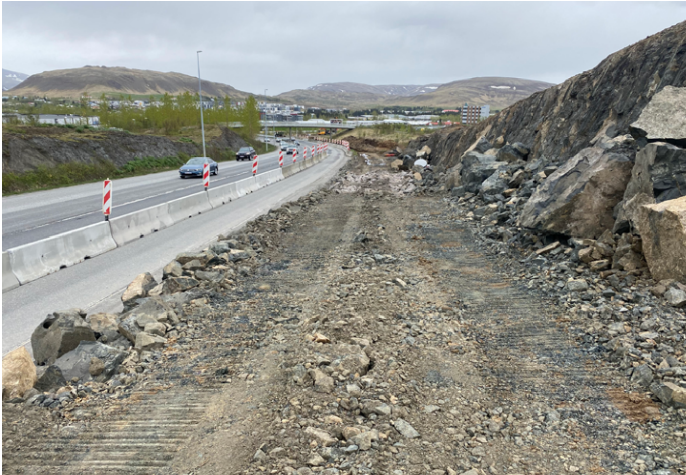
Endurbygging og breikkun Hringvegur (1) í Mosfellsbæ milli Langatanga og Reykjavegar.
