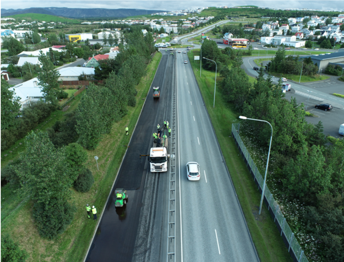
Gert við slitlag á Reykjanesbrautinni, milli hringtorgs við Lækjargötu og langleiðina að ljósum við Kaplakrika.
