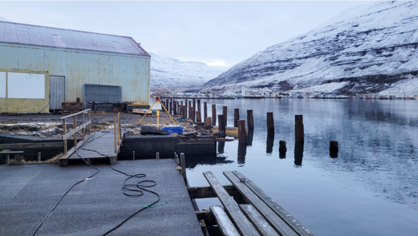
↓ Byrjað var á endurbyggingu gömlu Angróbryggjunnar á Seyðisfirði haustið 2022. Bryggjan var byggð úr harðviði sem fenginn var úr sjálfbærri skógrækt.
