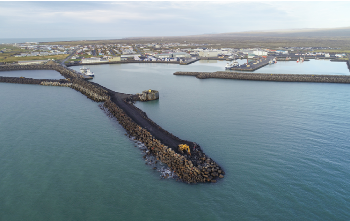
Unnið að lengingu Suðurvarargarðs í Þorlákshöfn.
