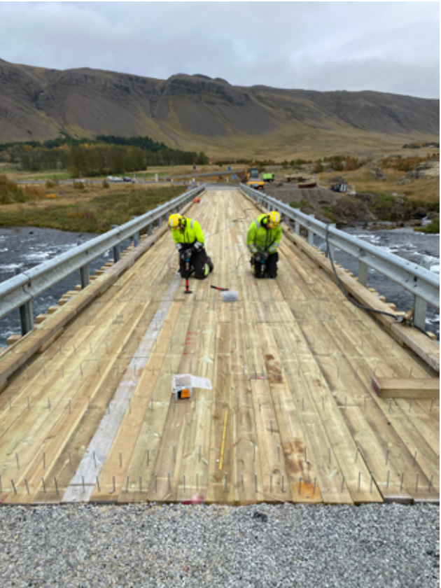
← Gert við brúna yfir Laxá í Kjós. Hér er brúarviðgerðin á síðustu metrunum, verið að festa gólfíð og vegrið komin upp.
