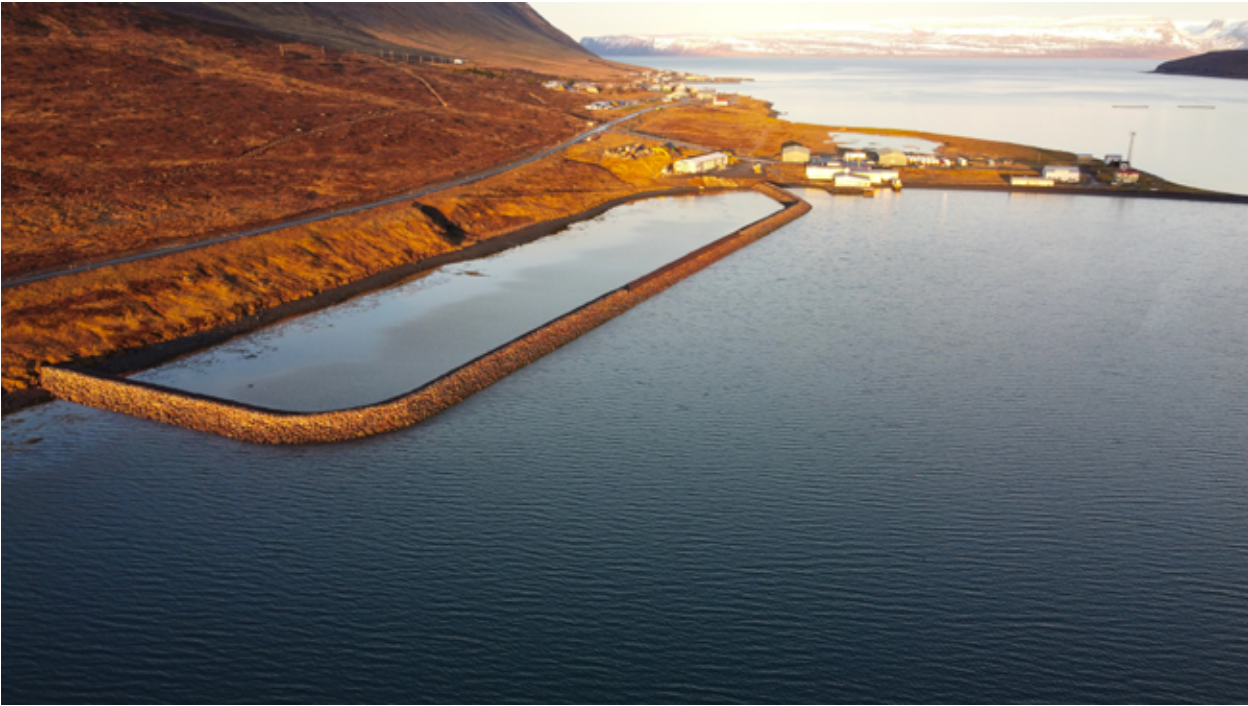
Bygging 30 þúsund fermetra landfyllingar og stálþilskants fyrir nýja kalkþörungaverksmiðju í Súðavík. Mynd: Þorsteinn Haukur Þorsteinsson.
