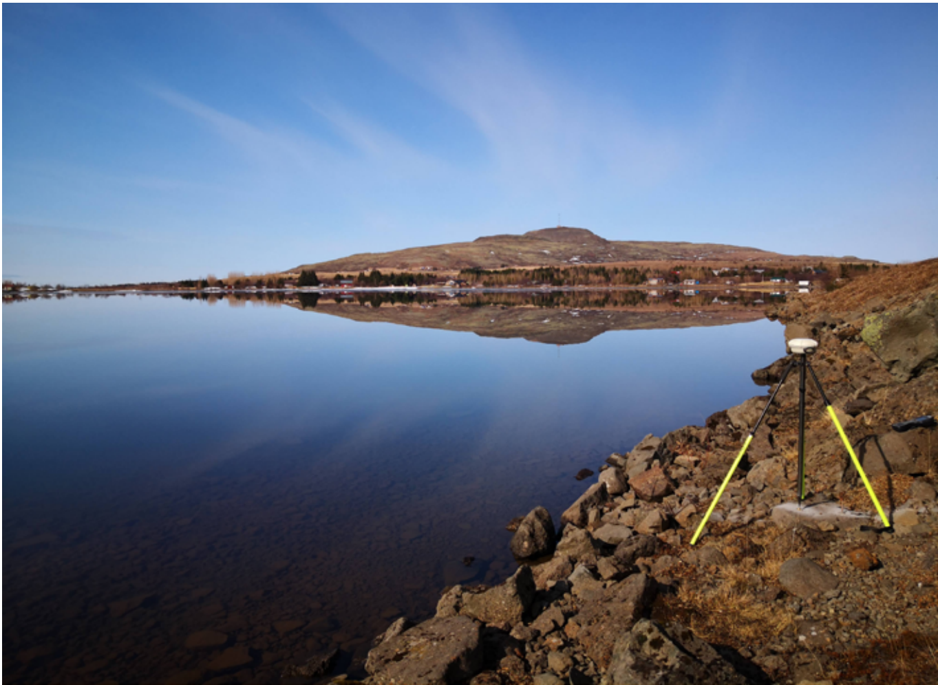
Fastamerkjumæling vegna lagfæringar á Hafravatnsvegi (431).
