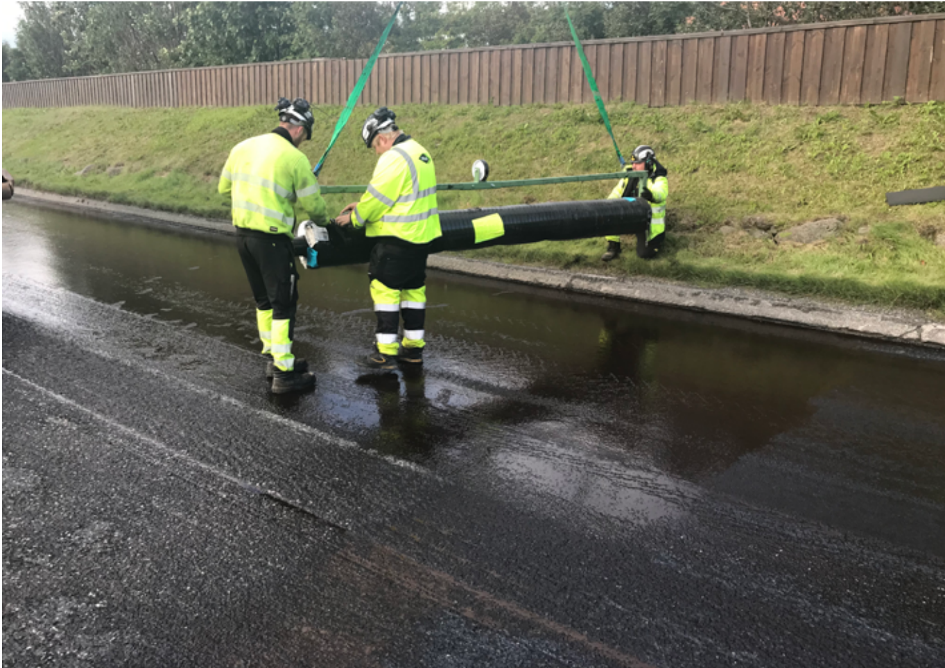
Unnið að lagningu malbiksdúks á Reykjanesbraut sem á að dreifa álagi á veginn og lengja líftíma hans.
