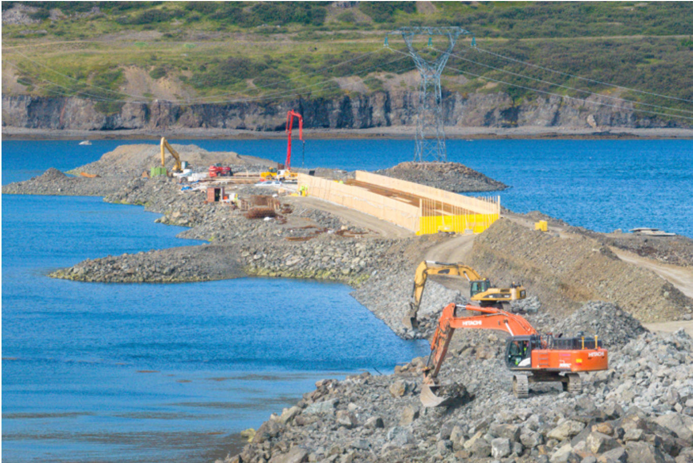
Unnið við þverun Þorskafjarðar sumarið 2022. Mynd: Haukur Sigurðsson
