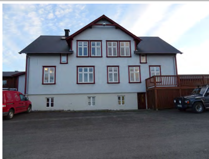
Húsið Framtíð 145 í núverandi mynd, horft til suðausturs.
