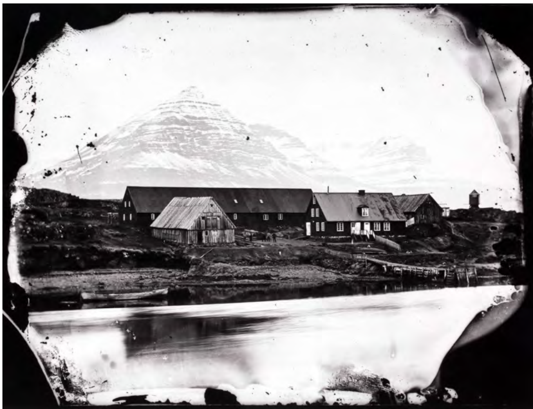
Ljósmynd eftir Nicoline Weywadt af kaupstaðnum á Djúpavogi. (Myn Th-5 í vörslu Þjóðminjasafns Íslands). Aftasta húsið er Langabúð 109. Framan við það vinstra megin er krambúð/skemma 071 og þar hægra megin er Faktorshús 084. Sibería 110 er hægra megin við Faktorshús og þá kornmylla 185 (utan verndarsvæðis).
