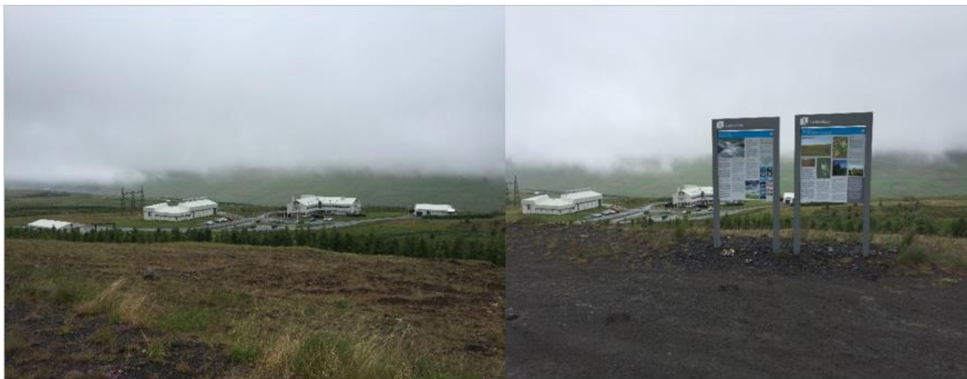
2. mynd. Blönduvirkjun séð frá norðurhluta Kjalvegjar og upplýsingaskilti við veginn fyrir ofan Blönduvirkjun. (Ljósmyndir: Anna Dóra Sæþórsdóttir, 2016).
