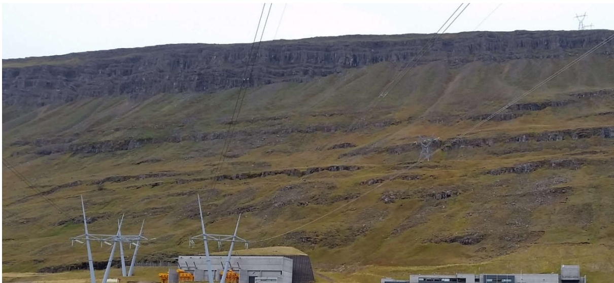
Mynd 4.23. Horft frá tengivirki í Fljótaldal upp Valbjófsstaðafjall.
