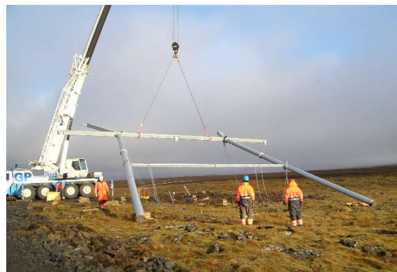
Mynd 3.9. Myndir sýna vinnu við samsetningu og reisingu stagaðs burðarmasturs af M-gerð. Myndirnar eru frá byggingu Reykjaneslínu 1.
