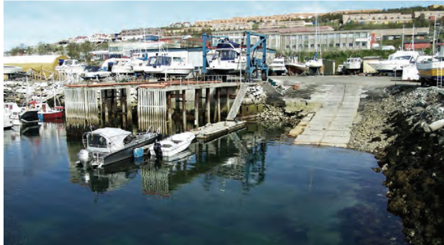
Mynd 10. Á slippstöð N3 er tvívenns konar búnaður til að taka báta á land; grind með lyftitaug og pallur þar sem dráttarvél dregur grind á hjólum.
