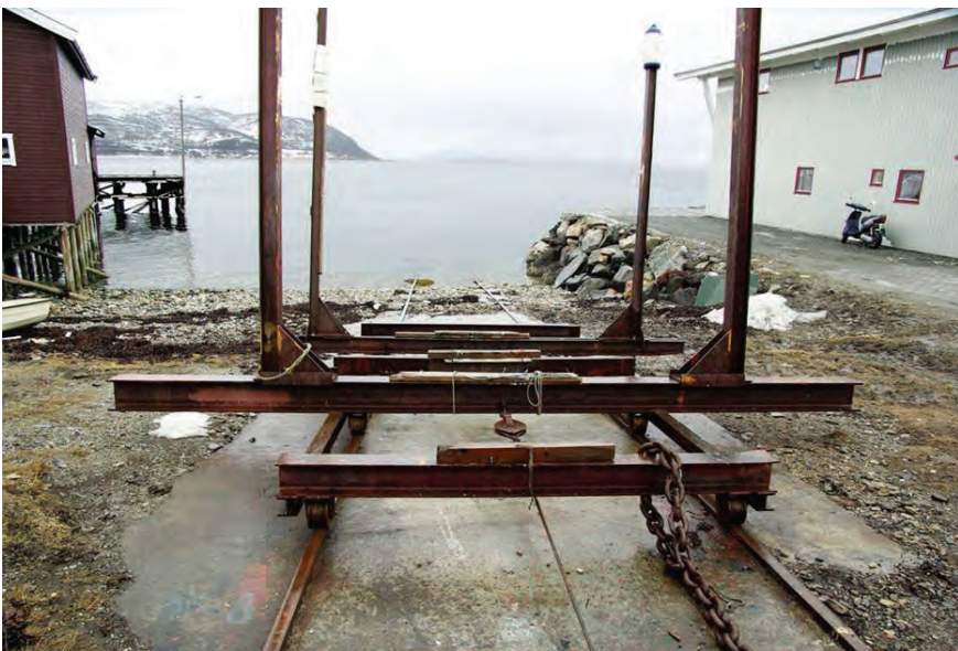
Mynd 2. Dráttarbraut á teinum með færanlegum stoðum.
