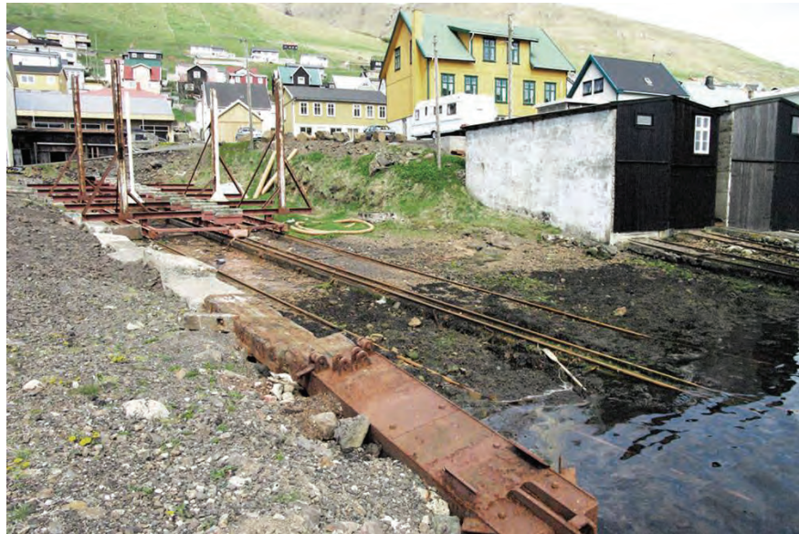
Mynd 46. Grind á teinum á ósteyptum jarðvegi á slippstöð F3.
