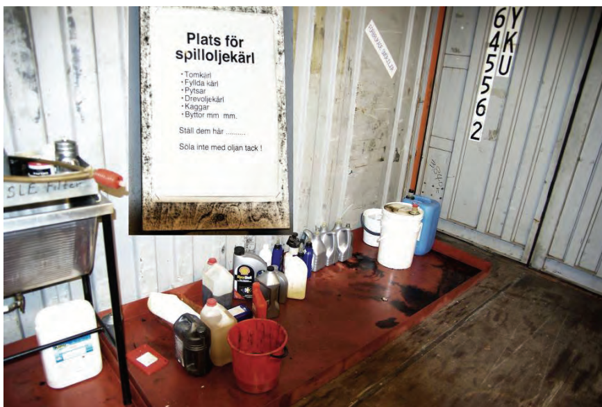
Mynd 29. Söfnunarker fyrir tómar og fullar könnur af úrgangsolíu á slippstöð Á3.
