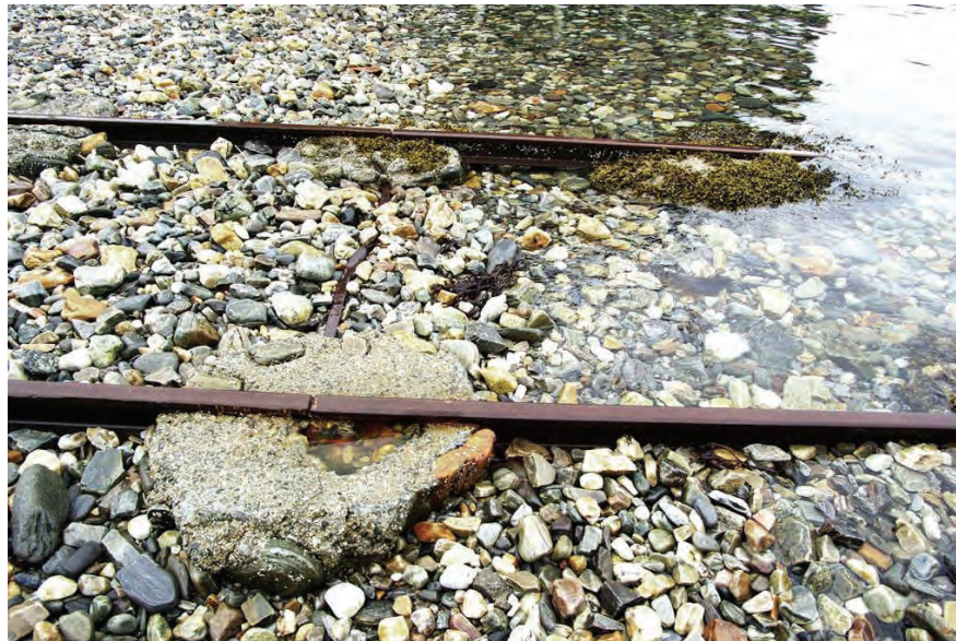
Mynd 3. Dráttarbrautin er brynvarin með sementi. Þangvaxnir steinar í fjörinni.
