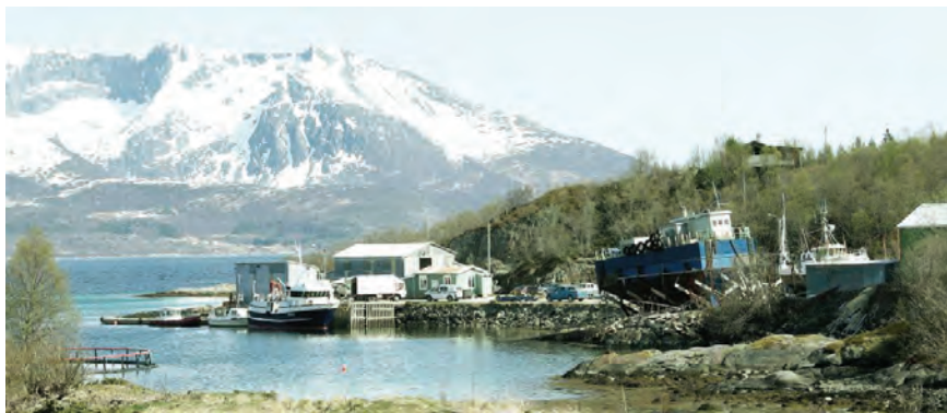
Mynd 5. Slippur N2 er við tiltölulega opið haf í strjálbýli.
