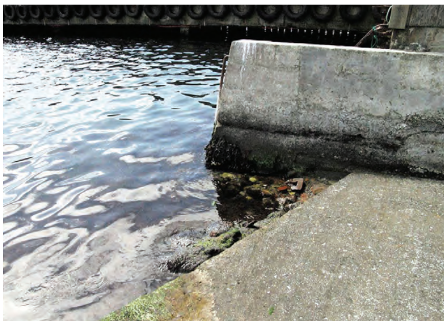
Mynd 48. Neðri kantur undirlagsins á slippstöð F3 þar sem ráðgert er að setja þverslá.
