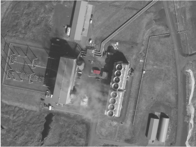
Lofmynd af CO 2 húsi milli Stöðvarhúss og kæliturna
