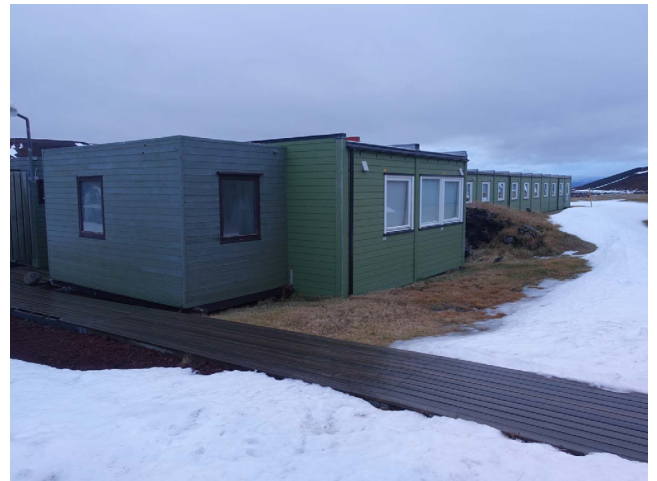
Séð eftir suðurhlið Austurskála
