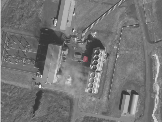
Lofthmynd af Brunadæluhúsi milli stöðvarhúss og Kæliturna
