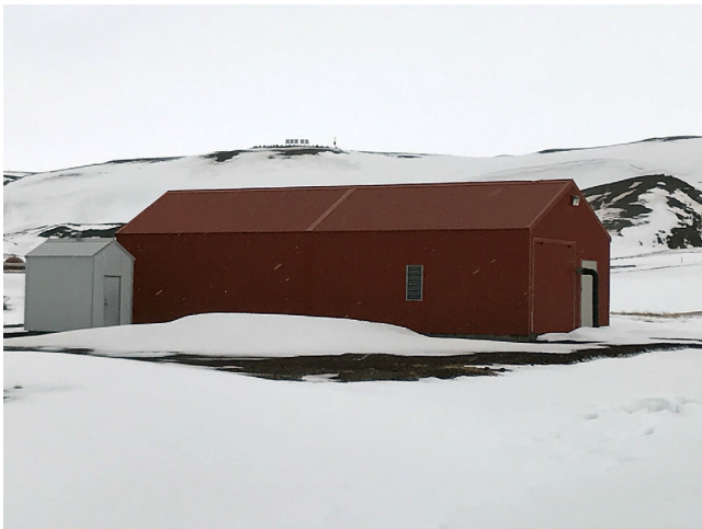
Dæluhús séð úr suðaustri Mynd: Steinn Ágúst Steinsson
