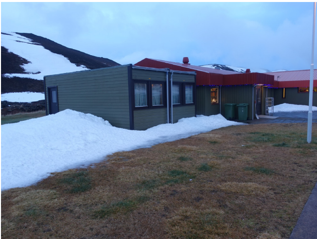
Færanlegar vinnubúðaeiningar við suðurenda
