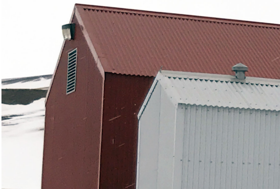
Einfaldur frágangur bárujárnklæðningar Mynd: Steinn Ágúst Steinsson
