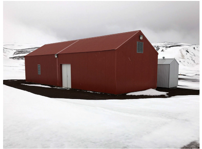
Dæluhús séð frá norðvestri Mynd: Steinn Ágúst Steinsson
