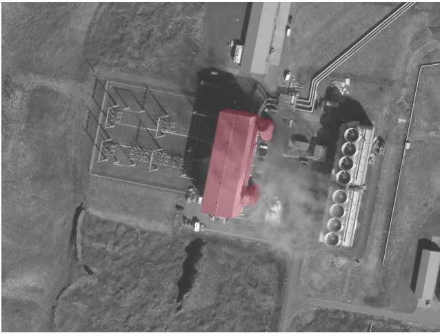
Lofmynd af stöðvarhúsi og kæliturnum
