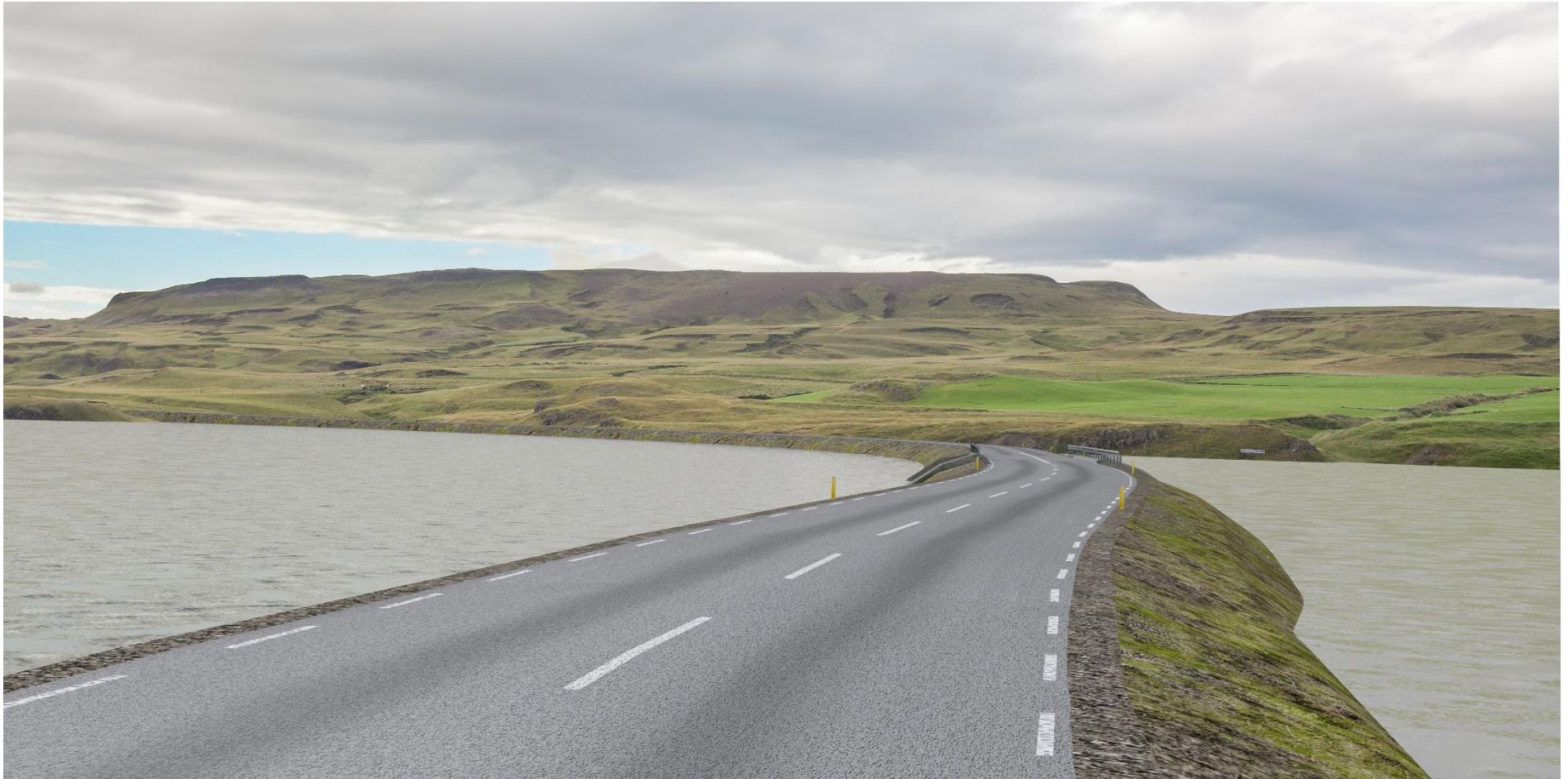
Mynd 75 Sjónarhorn 9. Ofan við Þjórsárdalsveg, austan við ármót Þjórsár og Þverár. Horft til suðvesturs – eftir framkvæmd.
