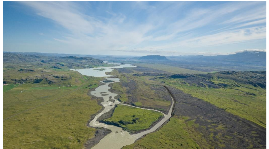
Mynd 5 Yfirflugsmynd af Þjórsá að sumri eftir framkvæmdir, horft í ANA frá Ölmóðsey. Myndin sýnir meðalrennsli að sumri í meðalvatnsári sem er 40 m 3 /s.
