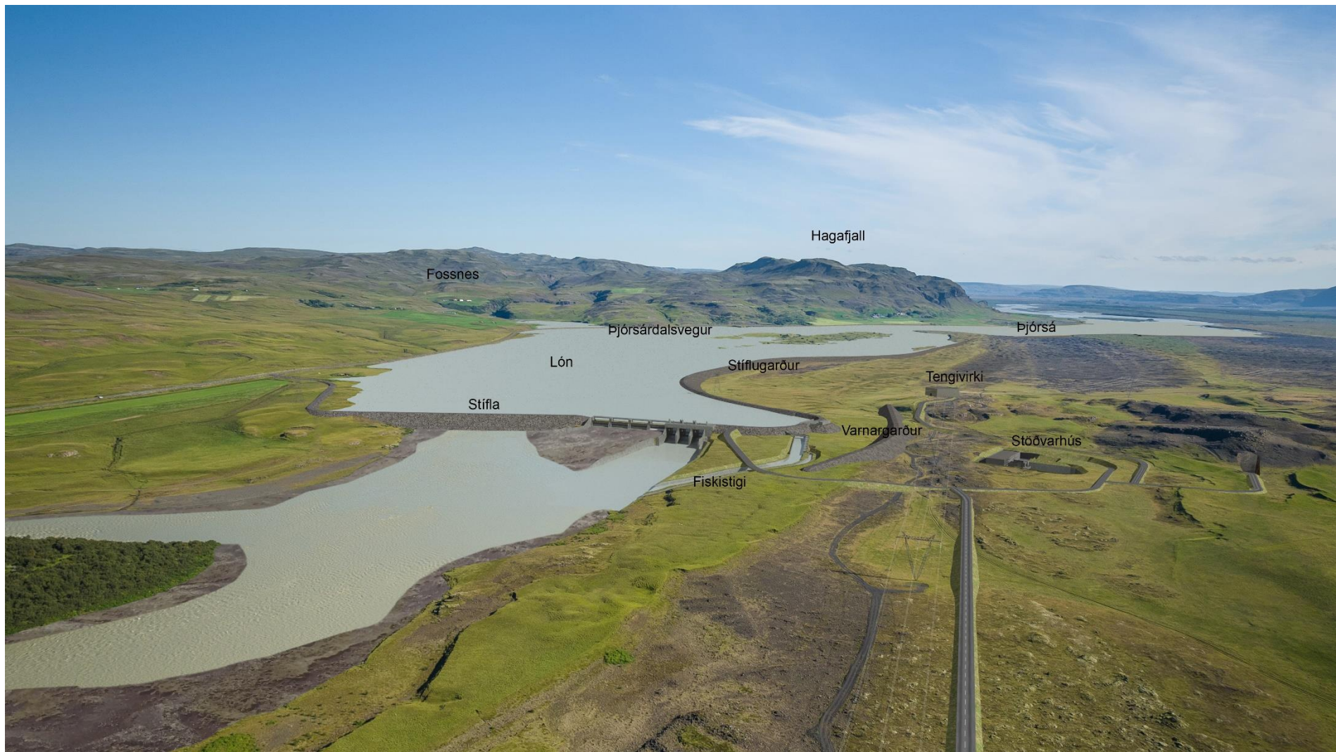
Mynd 1 Virkjanamannvirki Hvammsvirkjunar stax að lokinni framkvæmd. Sjá má sömu mynd með mismiklum uppgræðsluaðgerðum á myndum 134 og 135 í kafla 5, um mótnægisaðgerðir. Líkanmynd Mannvit.
