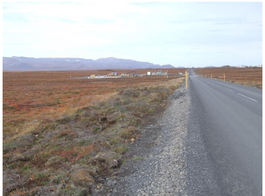
Mynd 16-17. Myndastaður 12 flutningur á gröðurtorfum og sett í vegkanta. Spennistöð sést í baksýn.
