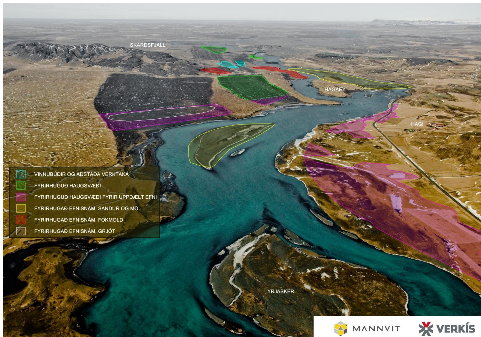
MYND 2.12 Horft í suður yfir framkvæmdasvæðið. Myndin sýnir efnistökusvæði, haugsetningu, vinnubúðir og aðstöðu verktaka.
